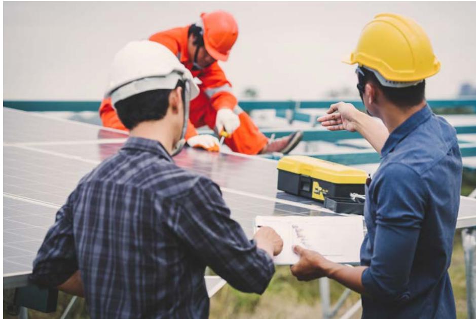
Görsel 2.2: Güneş enerjisi (fotovoltaik) proje kontrolü
