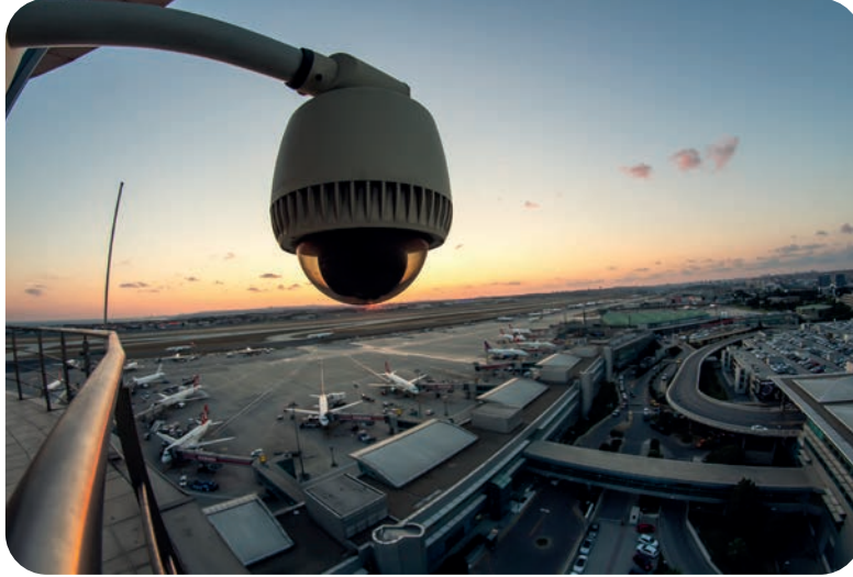
Görsel 1.9: Havaalanı kamerası
