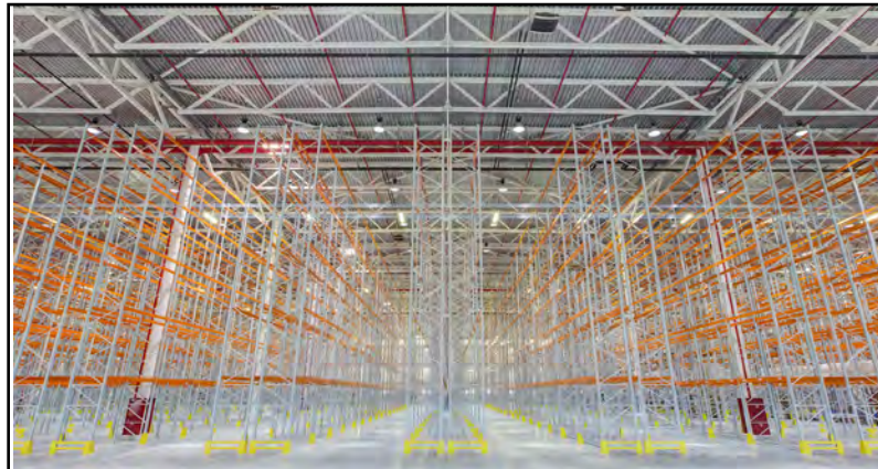
Görsel 5.10: Giydirme raf sistemleri
