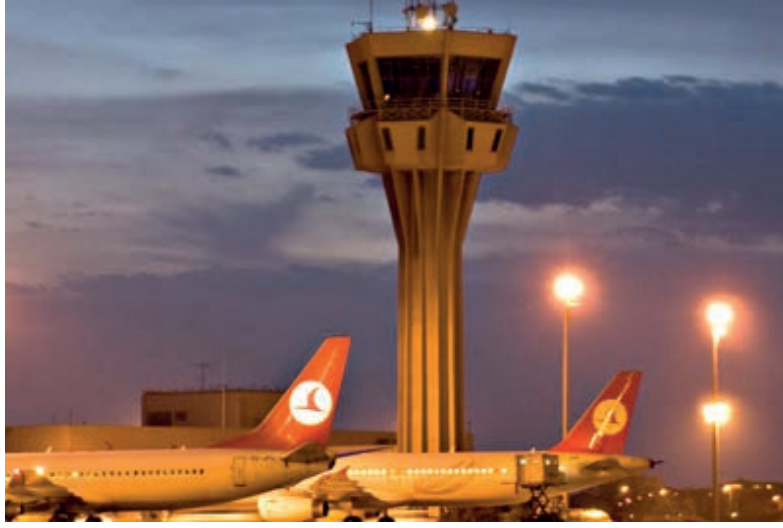
Görsel 1.2: Havalimanı trafik kontrol kulesi
