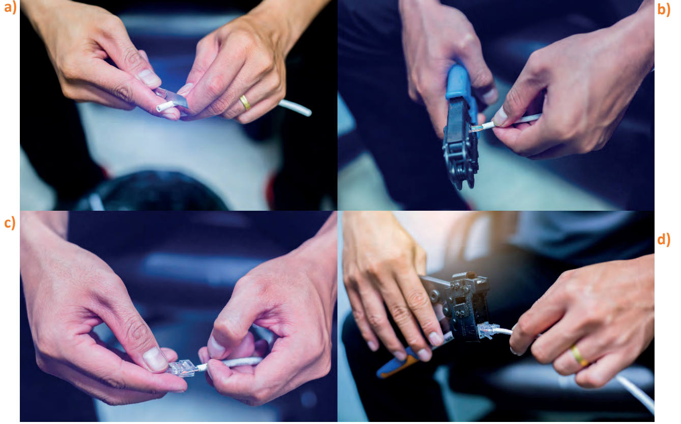
Görsel 5.21: RJ45 soket bağlantısının yapılması
