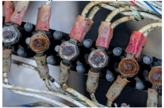
Görsel 5.28: Gözle kontrolde tespit edilebilecek olumsuz durumlara örnekler
