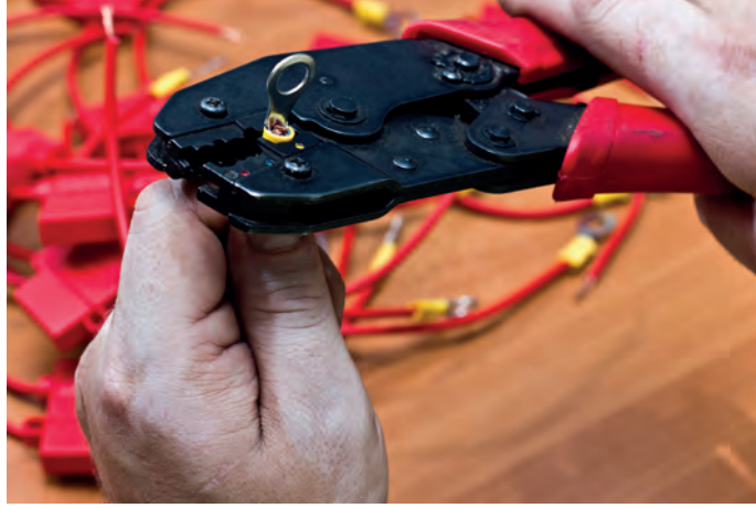
Görsel 5.14: Sıkıştırma aleti ile kablo pabucunun sıkıştırılması
