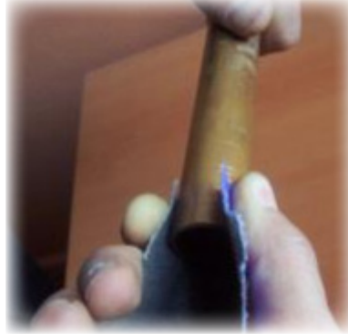
Görsel 6.11: Bakır borunun zımpara ile temizlenmesi
