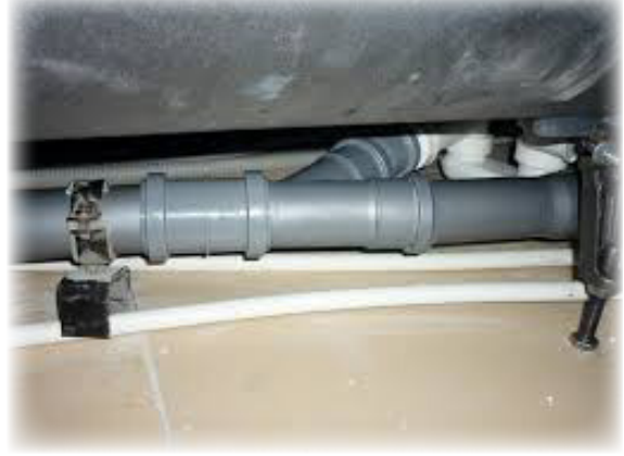
Görsel 5.18: PVC boru yatay birleştirme
