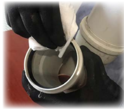
Görsel 5.17: PVC boru conta takılması
