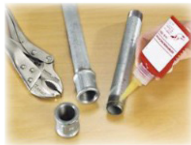
Görsel 4.23: Sıvı conta sürülmesi
