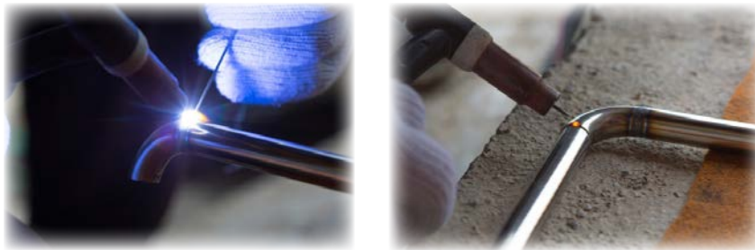
Görsel 13.23: TIG bakır boru kaynağı
