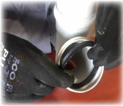
Görsel 5.17: PVC boru conta takılması
