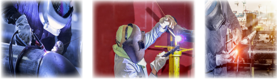
Görsel 13.18: TIG boru kaynağında çeşitli kaynak pozisyonları
