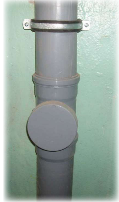
Görsel 5.19: PVC boru dikey birleştirme
