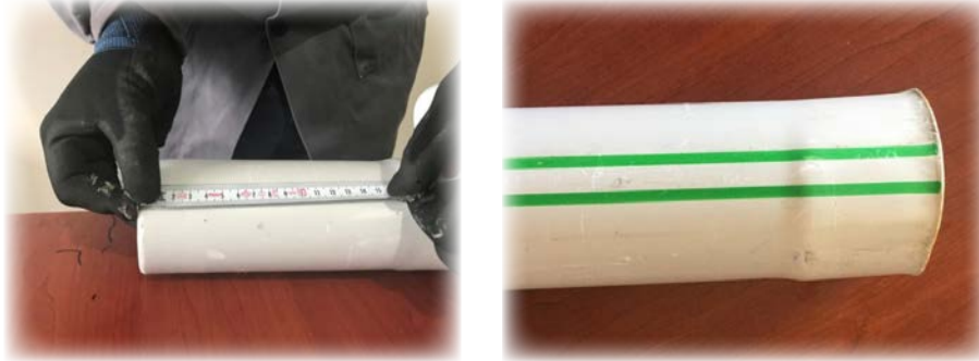
Görsel 5.22: Muf açılmış boruyu birleştirme aşamaları
