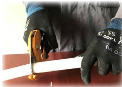
Görsel 5.3: Polipropilen boru kesme aşamaları
