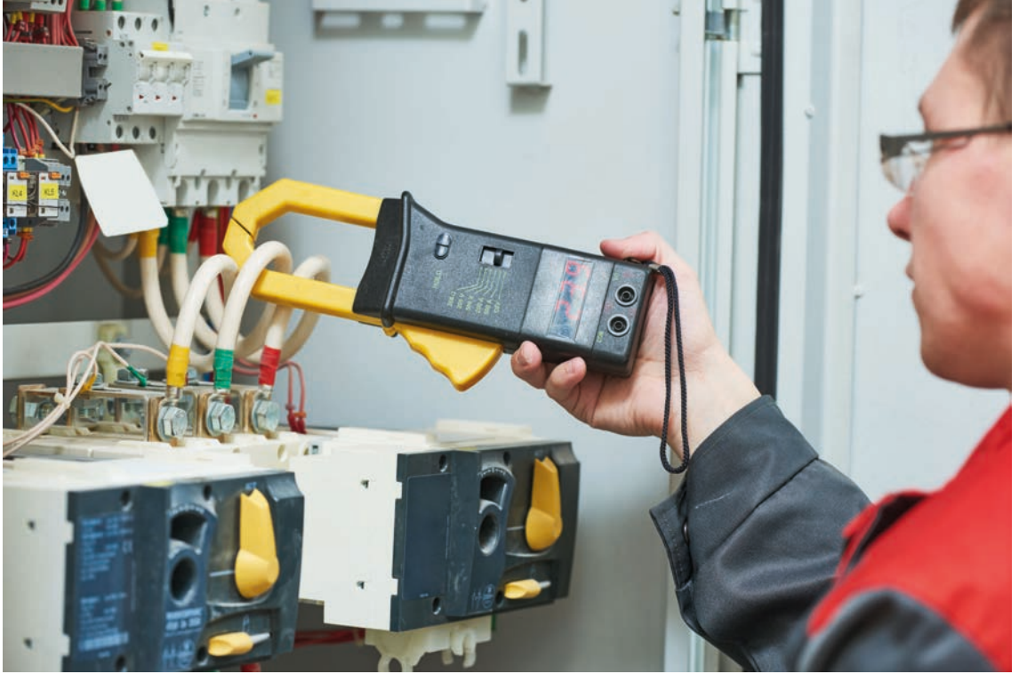
Görsel 5.30: Pens ampermetre
