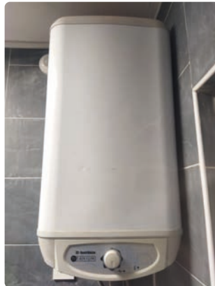
Görsel 7.6: Askı braketine montajı yapılmış termosifon
