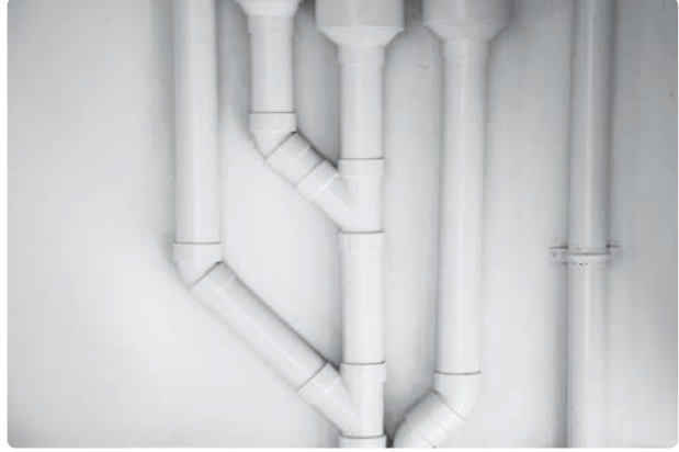
Görsel 4.3: Düşeyde döşenmiş PVC boru
