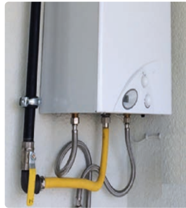
Görsel 7.3: Şofbenin doğal gaz ve tesisat bağlantıları
