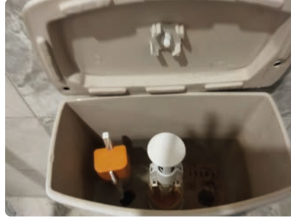
Görsel 11.8: Rezervuar montajı yapılmış iç takım
