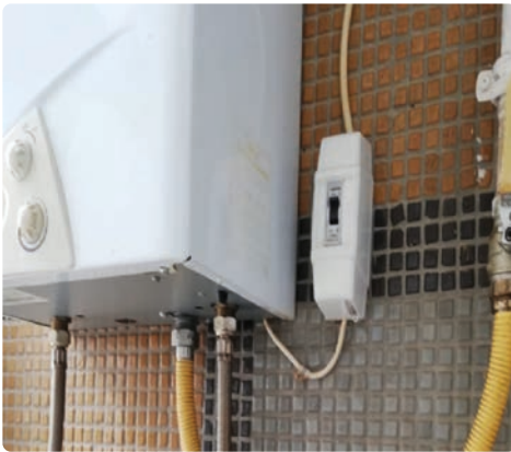
Görsel 7.3: Şofbenin doğal gaz ve tesisat bağlantıları
