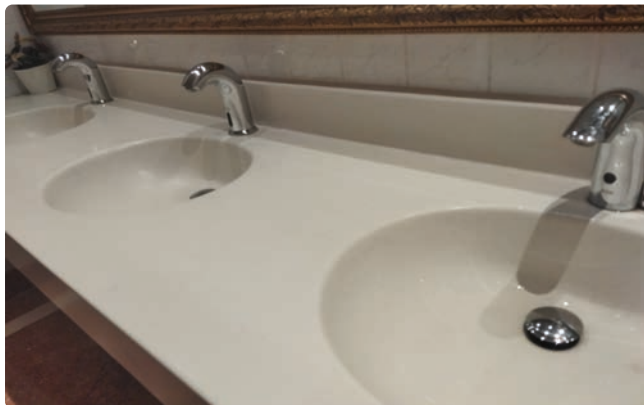
Görsel 6.12: Fotoselli batarya montajı yapılmış lavabo
