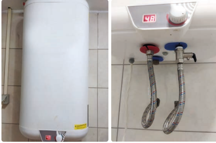
Görsel 7.8: Termosifon montaj ve tesisat bağlantıları
