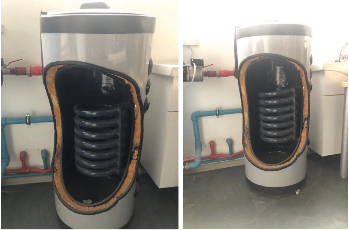
Görsel 7.9: Serpantinli boyler bağlantıları ve iç kesidi
