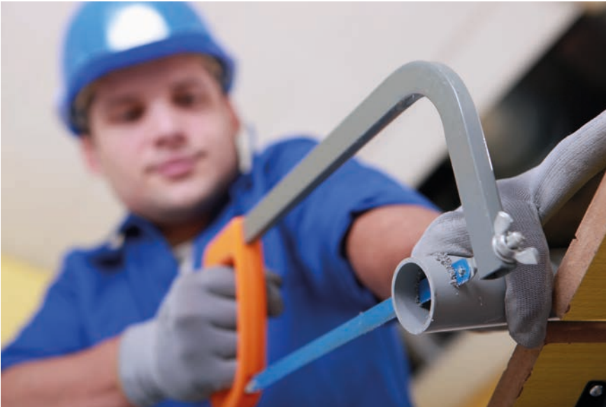
Görsel 4.4: PVC boruların ölçüsünde kesilmesi
