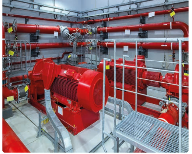
Görsel 8.1: Sulu yangın söndürme sistemleri
