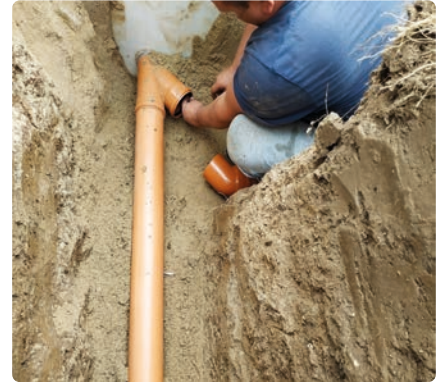
Görsel 4.9: PVC borunun kanalizasyona bağlantısı
