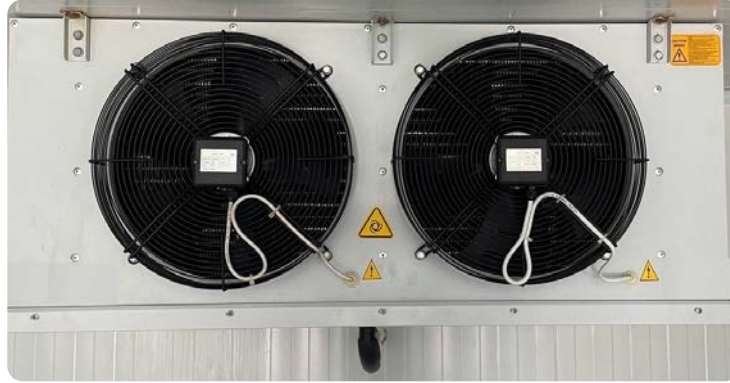
Görsel 4.5: Montajı yapılmış evaporatör
