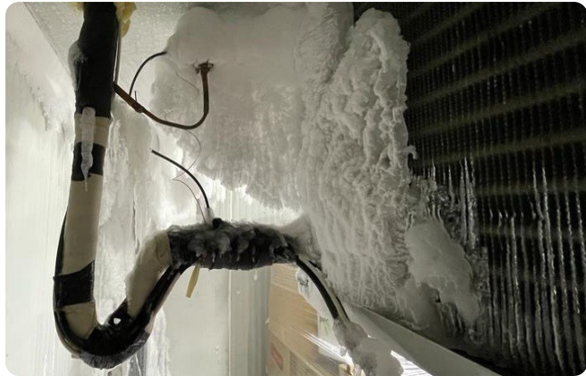
Görsel 4.6: Defrost sistemi çalışmayan evaporatör
