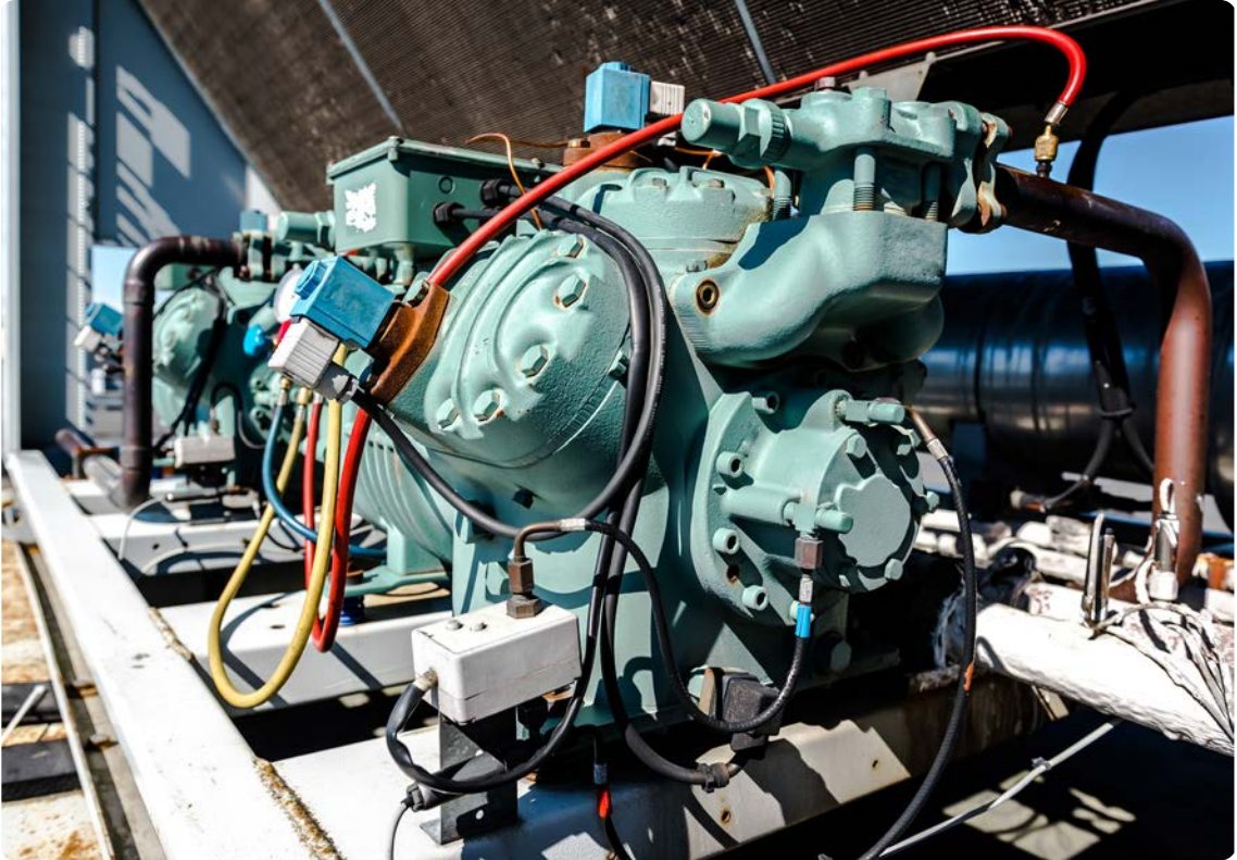
Görsel 4.4: Kompresör montajı ve bağlantı elemanları
