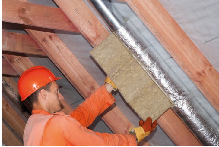
Görsel 4.17: Yuvarlak (silindirik) kesitli hava kanalının klima şiltesi ile yalıtımı
