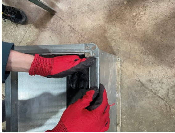
Görsel 3.10: Yalıtım malzemesini yapıştırma
