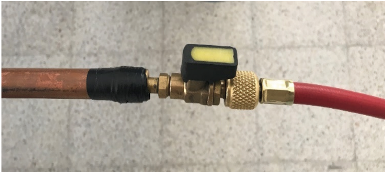
Görsel 12.12: Azot regülatörüyle boru bağlantısı
