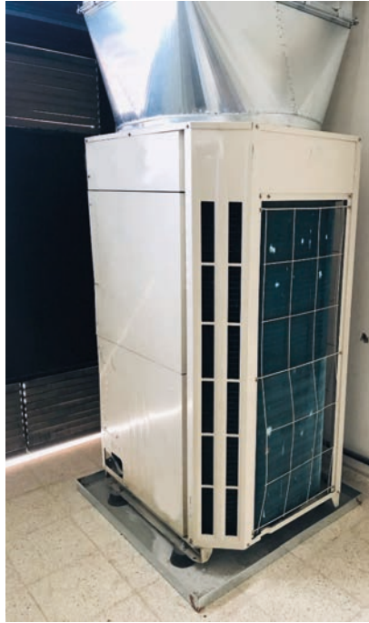
Görsel 12.6: Montajı tamamlanmış dış ünite
