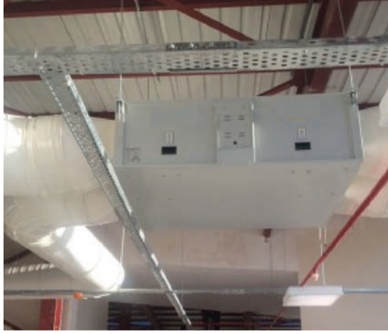
Görsel 11.2: Isı geri kazanım cihazı montajı
