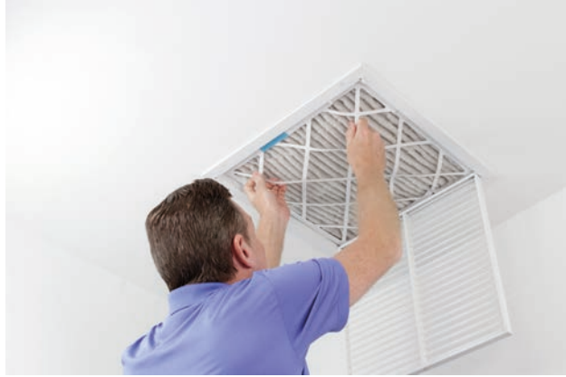
Görsel 5.4: Havalandırma sistemlerinde filtre bakımı
