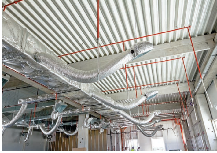
Görsel 3.4: Esnek kanal bağlantısı
