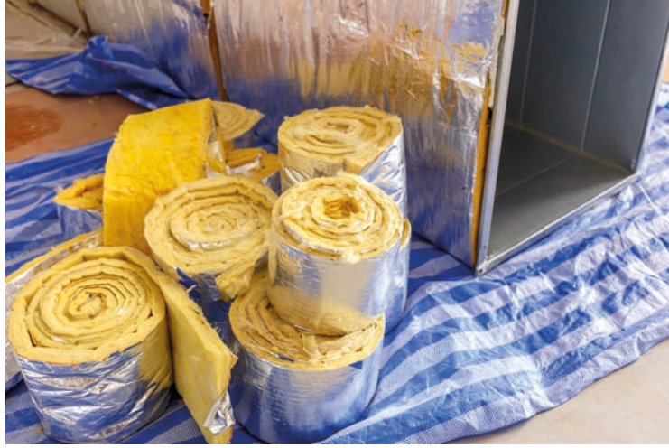
Görsel 4.19: Klima levhası ile kanal yalıtımı
