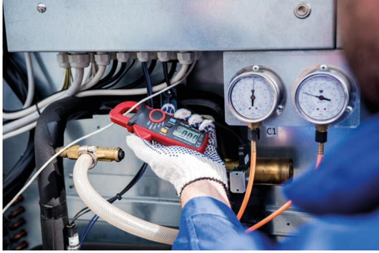
Görsel 5.15: Pens ampermetre
