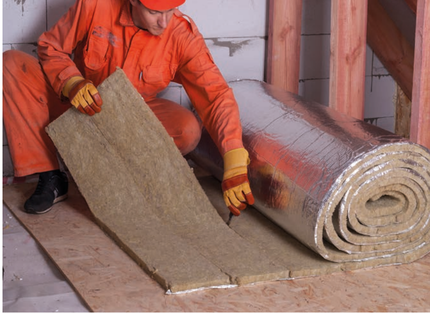
Görsel 4.14: Isı yalıtım malzemesinin kesimi
