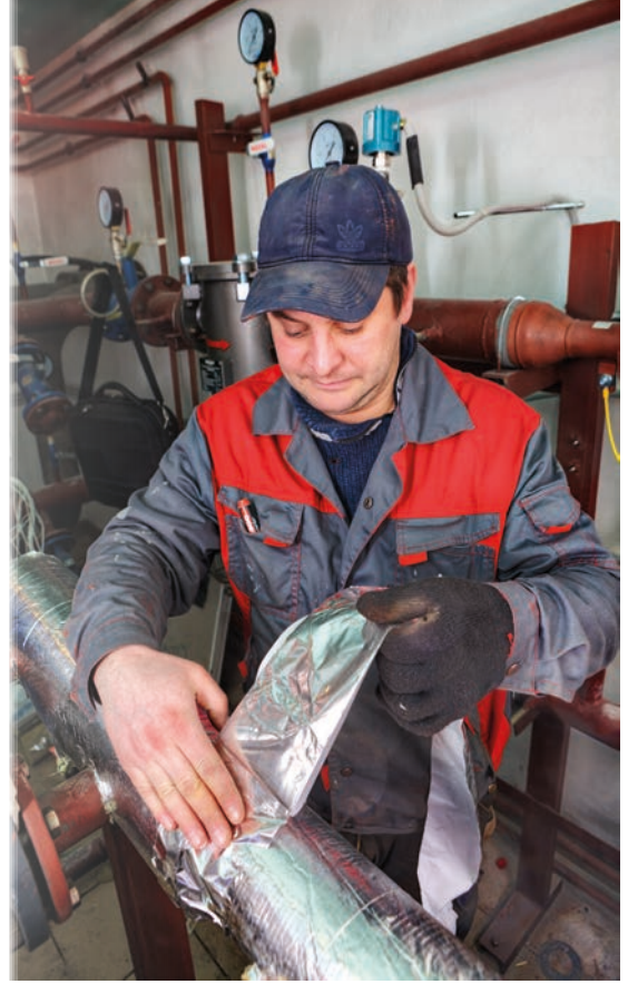
Görsel 4.9: Hava kanalına yalıtımı yapıştırma
