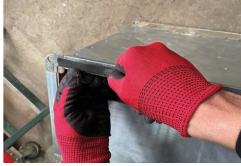
Görsel 3.8: Flanşlı parçaya conta yerleştirme
