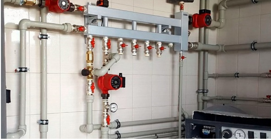
Görsel 10.11: Sirkülasyon pompası bağlantı şeması
