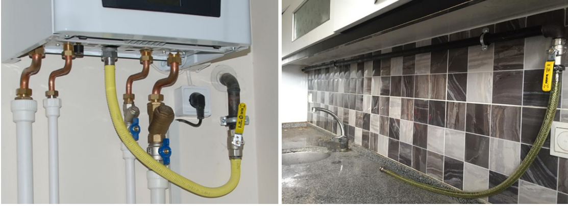
Görsel 4.13: Cihaz bağlantı hattı montajı
