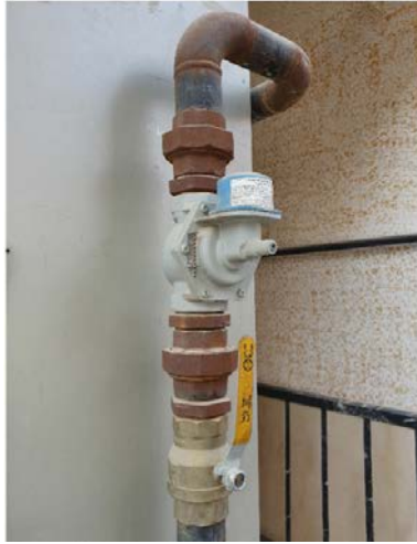
Görsel 3.10: Mekanik deprem vanası montaj şeması
