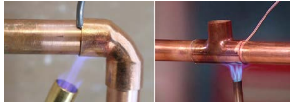
Görsel 4.6: Bakır boru lehimleme
