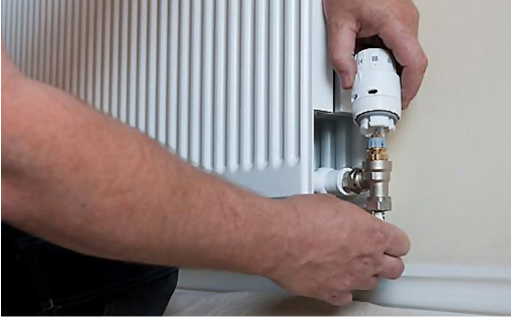
Görsel 9.31: Termostatik vana montajı
