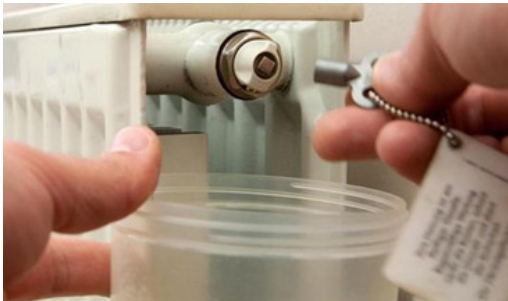
Görsel 9.25: Radyatör üzerinden hava alma vidası
