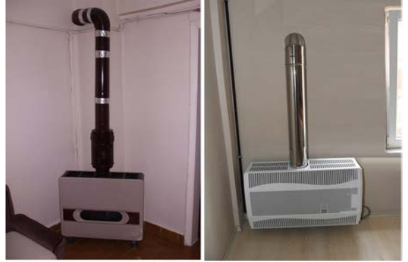
Görsel 5.3: Bacalı ve hermetik doğal gaz sobası
