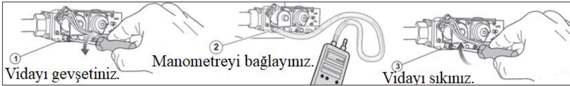
Görsel 4.32: Gaz giriş basıncının ölçülmesi
