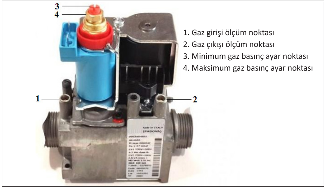
Görsel 4.21: Maksimum ve minimum gaz basınç ayarlarının yapılması
