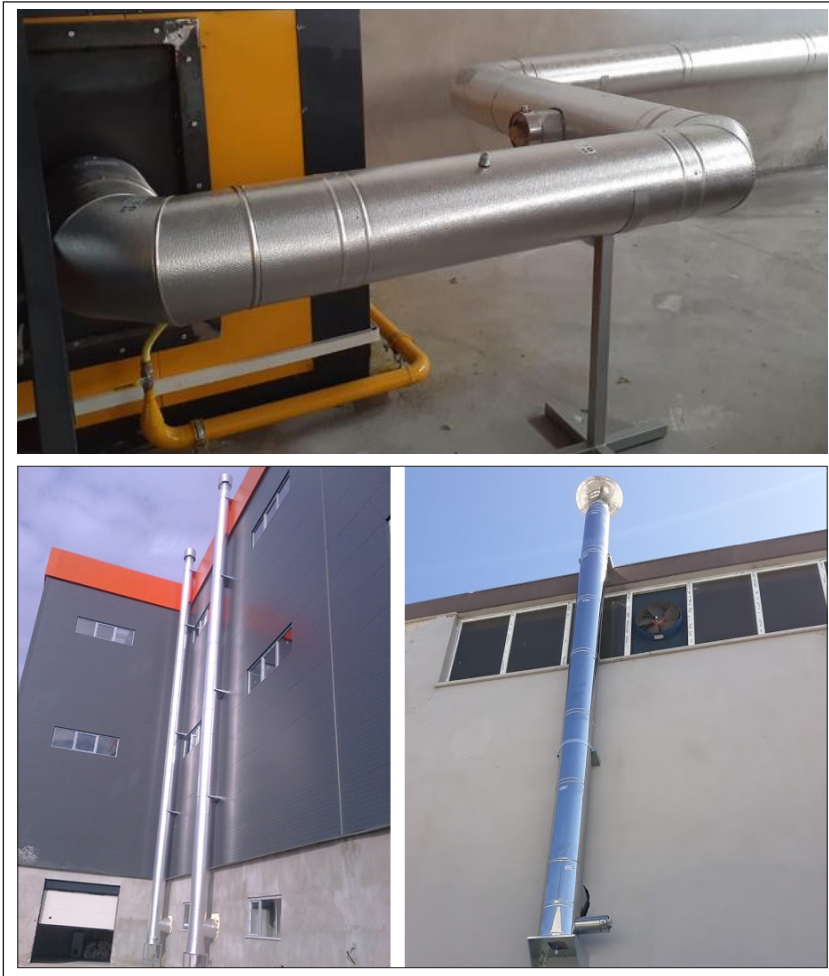
Görsel 2.11 : Doğal gaz çelik baca montaj örnekleri
