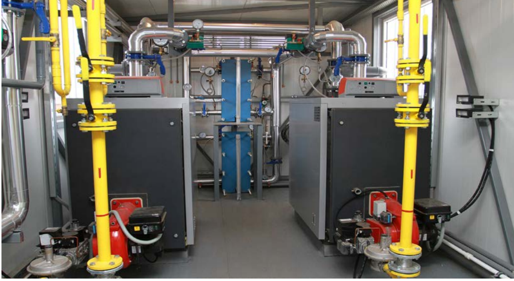
Görsel 4.30: Doğal gaz kazanlarını devreye almak ve kazanların verimliliğini test etmek
