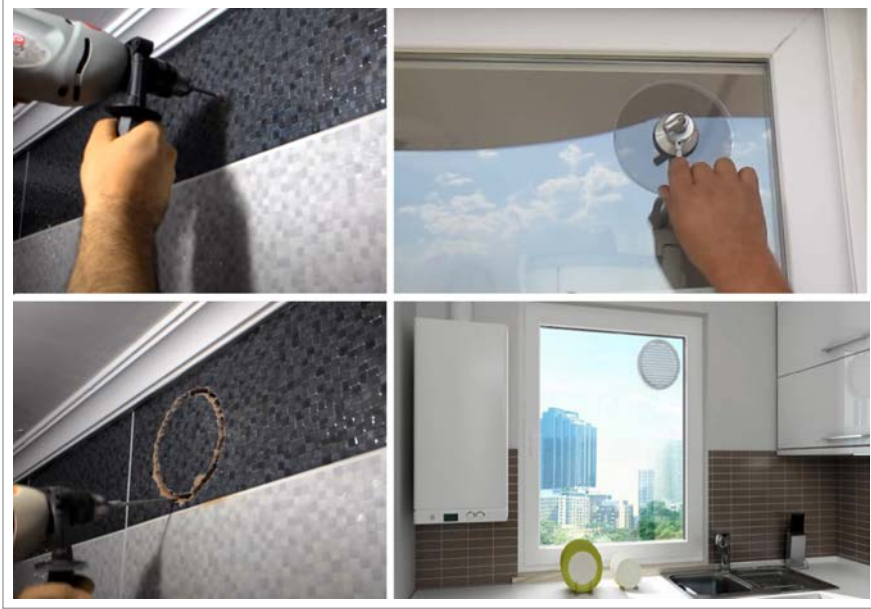
Görsel 2.22: Duvara veya cama menfez montajı açmak
