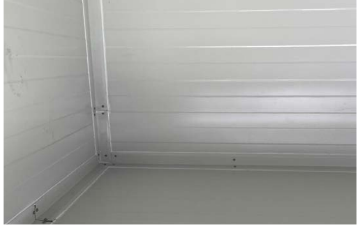
Görsel 6.9: Taban panel döşeme montajı
