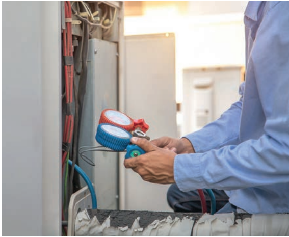
Görsel 9.7: Kompresör çalışma kontrolü
