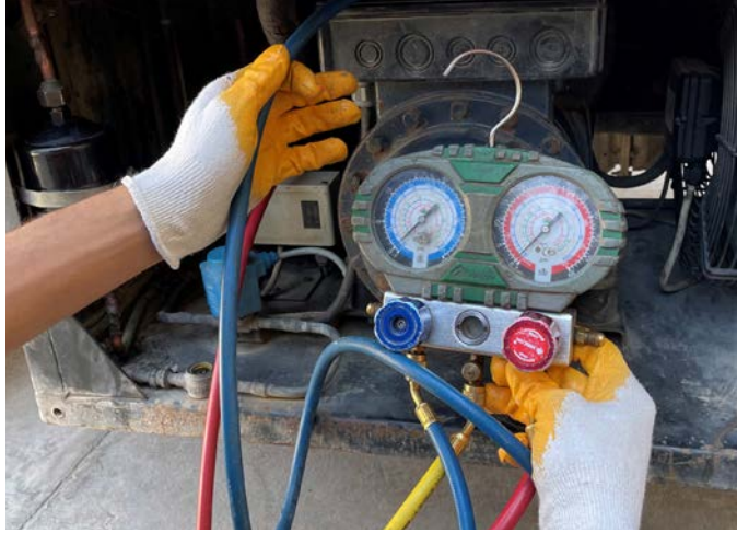
Görsel 7.28: Vakumlama ve azot testi
