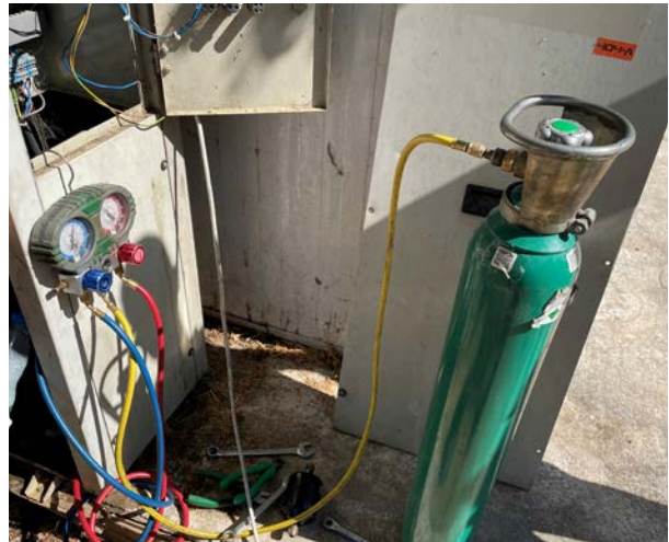
Görsel 7.20: Azot tüpü bağlantısı
