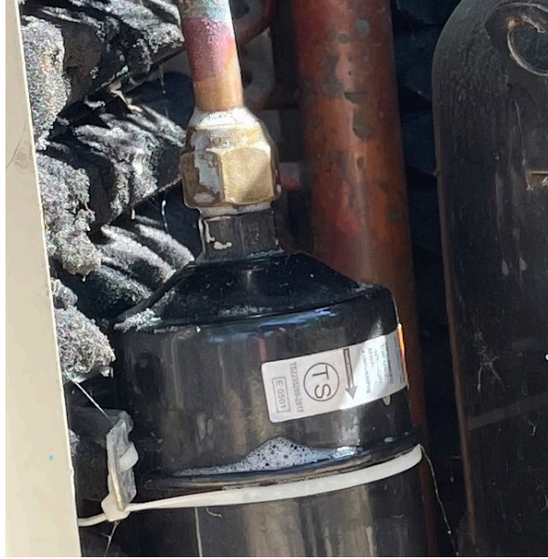
Görsel 7.17: Drayer montaj bağlantısı
