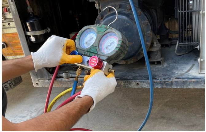
Görsel 7.19: Soğutma devresine vakum bağlantısı
