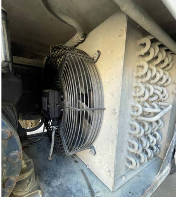
Görsel 7.11: Kondenser montajı
