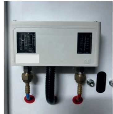
Görsel 9.8: Alçak ve yüksek basınç anahtarı
