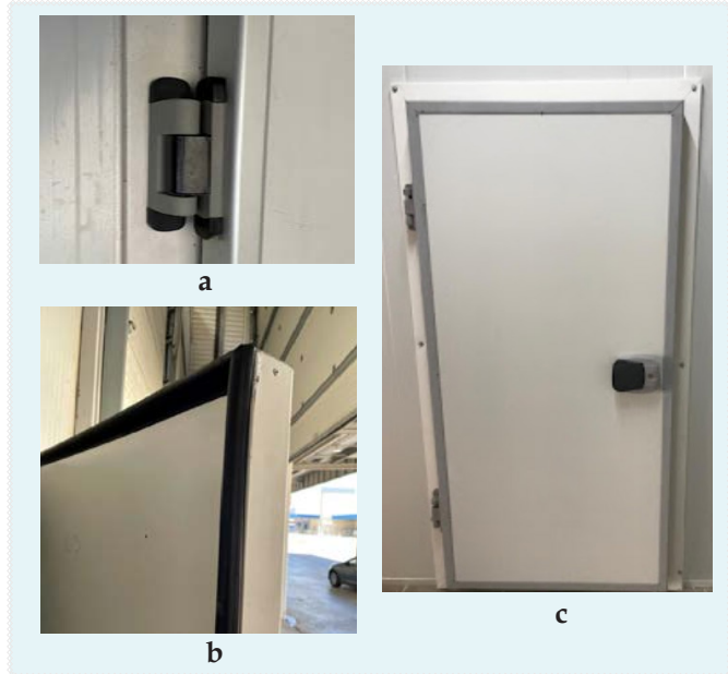
Görsel 6.14: Menteşeli soğuk oda kapısı ve kapı rezistansı
