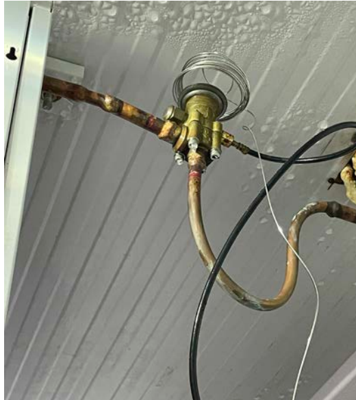
Görsel 7.14: Termostatik genleşme valfinin diğer devre elemanlarıyla bağlantısı
