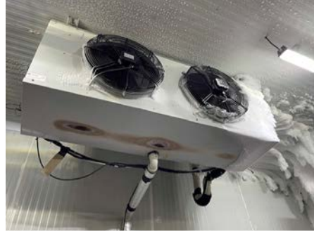
Görsel 6.4: Drenaj kanalı
