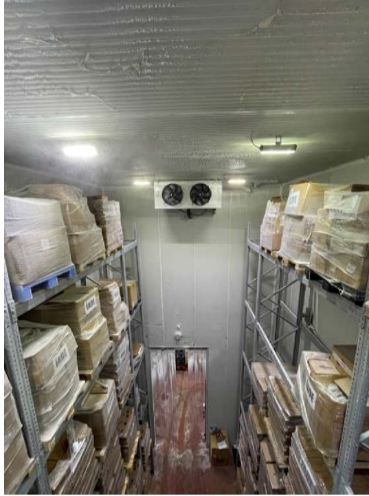
Görsel 7.12: Soğuk oda evaporatör yerleşimi
