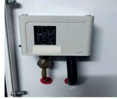
Görsel 9.9: Kondenser fanlarının emniyet basınç anahtarı ile kontrolü
