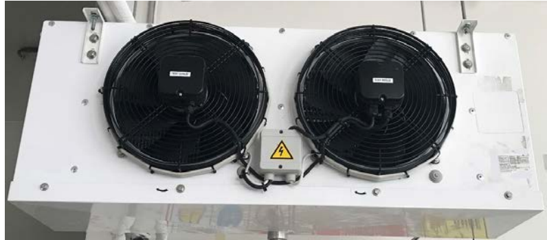
Görsel 1.11: Evaporatör (buharlaştırıcı)
