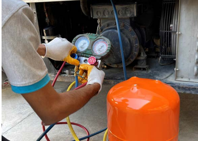
Görsel 7.29: Vakumlama ve azot testi
