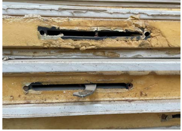
Görsel 6.11: Yan duvar panellerinin birbirine kilitlenerek montajı
