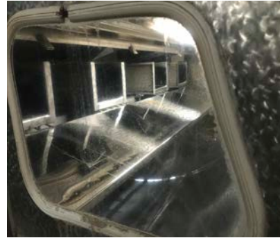
Görsel 4.16: Dinkleme işleminin yapıldığı kısım
