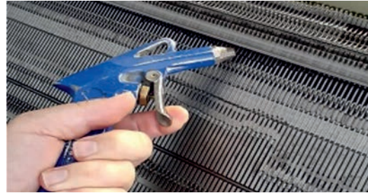
Görsel 5.16: Makine plakasının hava ile temizlenmesi
