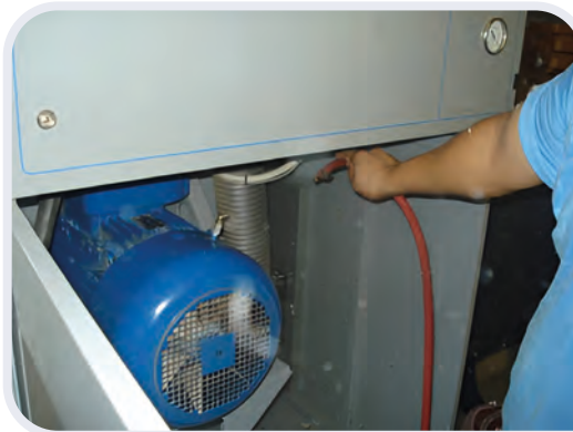
Görsel 1.40: Bobin makinesi motorunun temizlenmesi
