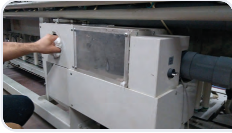
Görsel 1.25: Emiş fan motor filtresi
