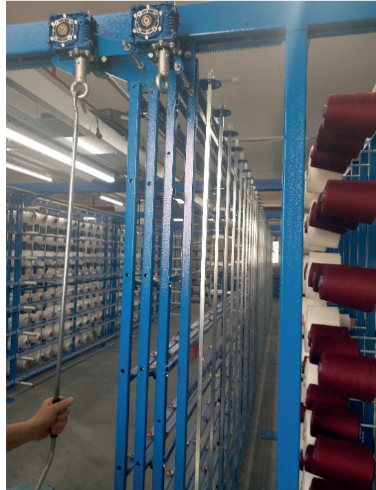
Görsel 1.29: Çağlık kanadının kapatılması
