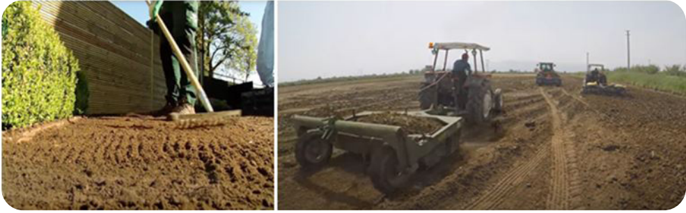
Görsel 11.3: Tırmık ve tesviye kürekleri ile kaba tesviye yapılması
