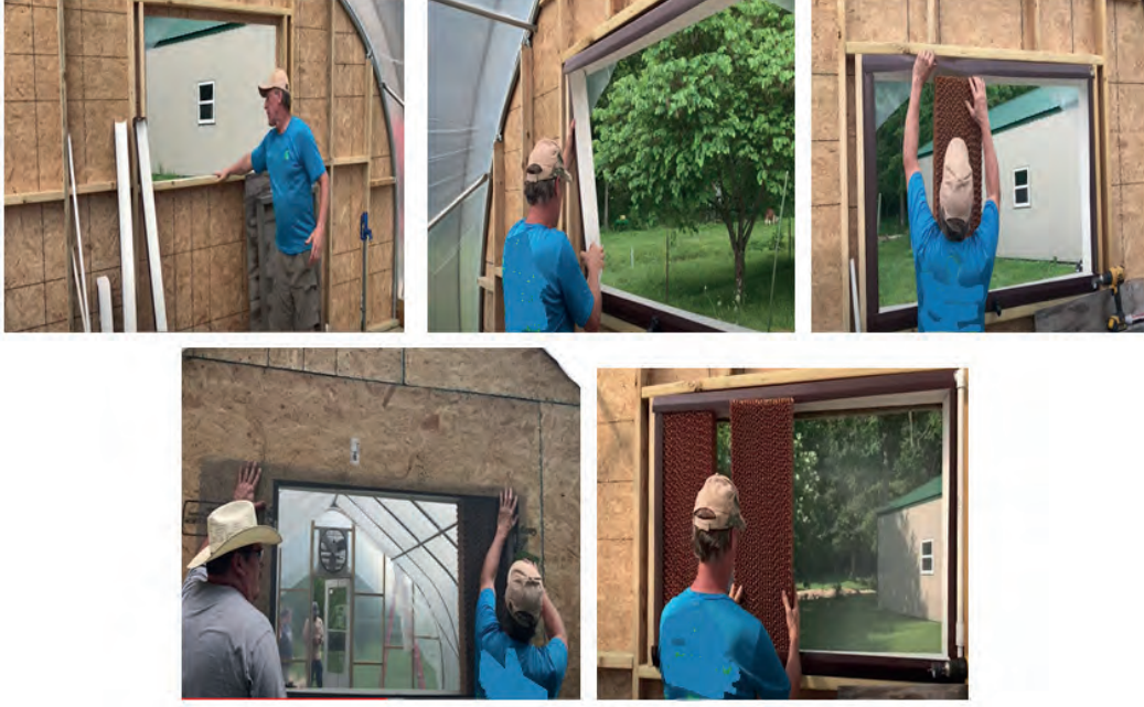
Görsel 4.32: Soğutma yastıklarıyla soğutma sisteminin kurulması
