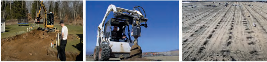
Görsel 4.2: Seranın temel çukurlarının açılması
