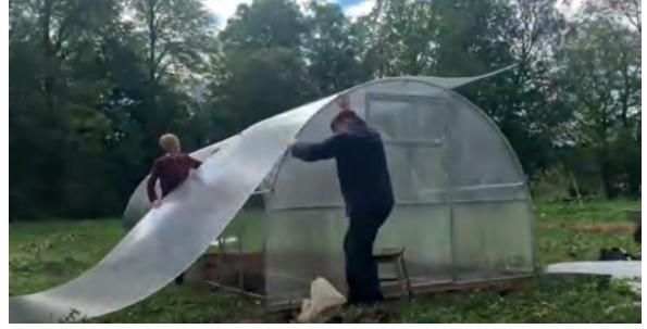
Görsel 4.11: Seranın polikarbon ile kaplanması
