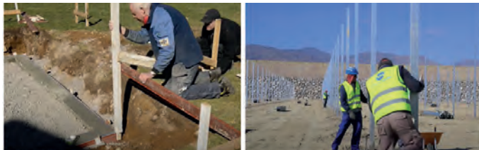
Görsel 4.3: Seranın temel kazıklarının çakılması
