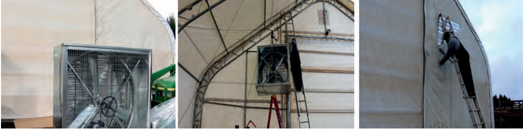
Görsel 4.18: Serada mekanik havalandırma sisteminin kurulumu
