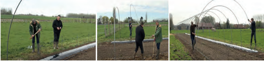
Görsel 3.26: Yüksek plastik tünellerde iskelet kurulumu
