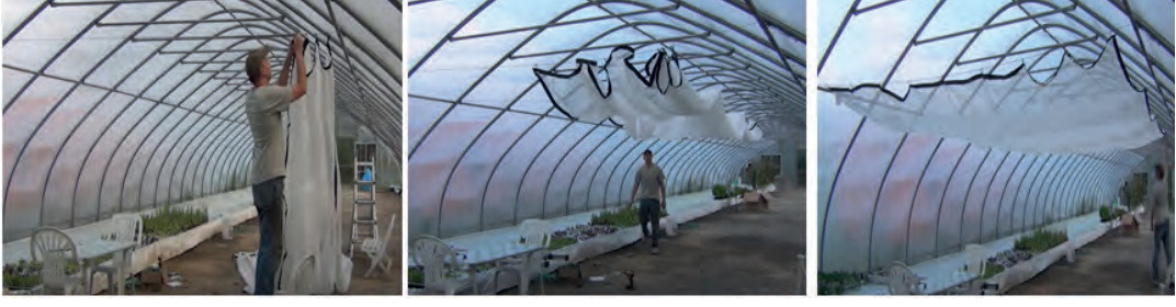
Görsel 4.26: Sera içerisinde gölgeleme perdesinin takılması
