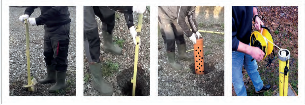
Görsel 3.7: Taban suyu seviyesini belirlemek için gözlem kuyusu açma ve ölçüm yapma
