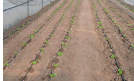
Görsel 5.65: Serada döşenmiş damla sulama sistemi
