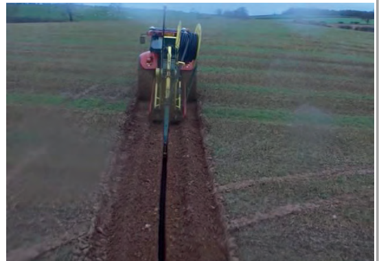
Görsel 3.10: Yüzey altı drenaj kanalları açılması
