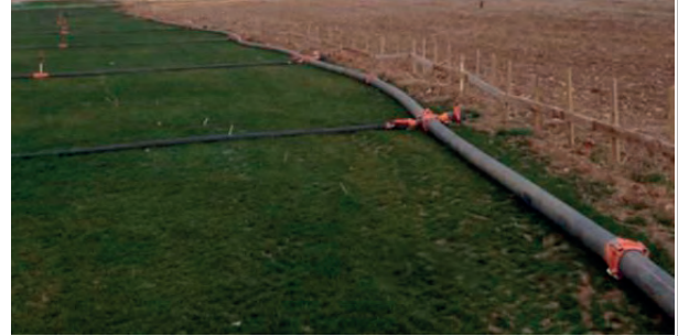
Görsel 5.75: Yağmurlama sulama sistemi ana ve lateral boru hattı
