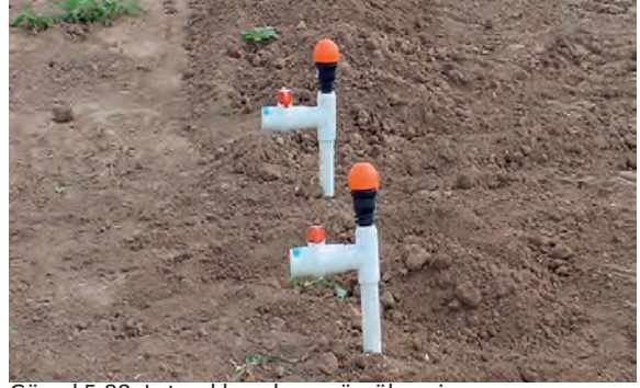
Görsel 5.88: Lateral boruların gömülmesi
