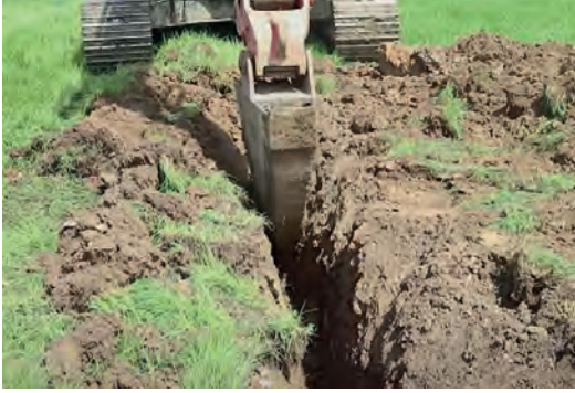
Görsel 3.11: Kapalı drenaj kanallarının açılması
