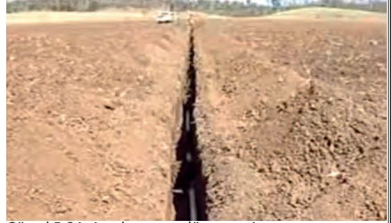
Görsel 5.84: Ana borunun döşenmesi
