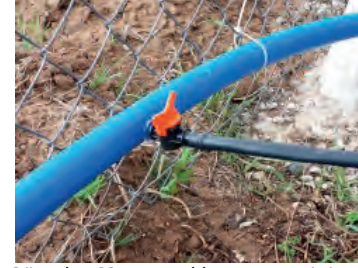
Görsel 5.63: Lateral borunun mini vanaya takılması
