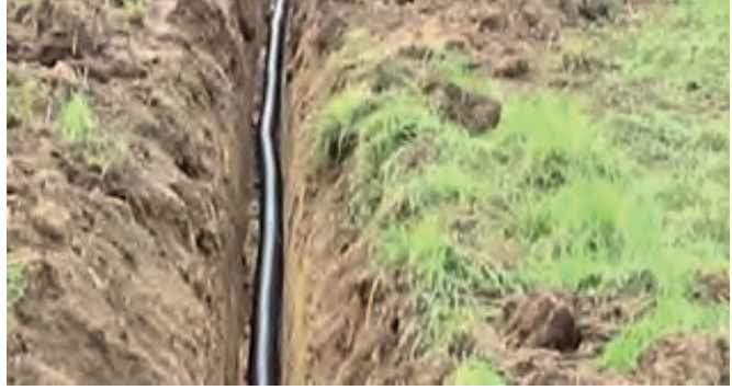
Görsel 3.12: Kanallara boruların yerleştirilmesi
