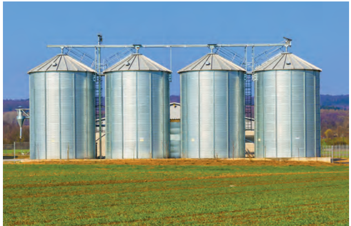
Görsel 3.11: Tahıl depolama siloları
