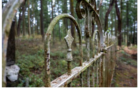
Görsel 1.58: Demirin paslanması (korozyon)
