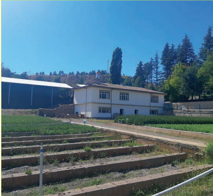
Görsel 1.24: Fidanlıkta işletme binası
