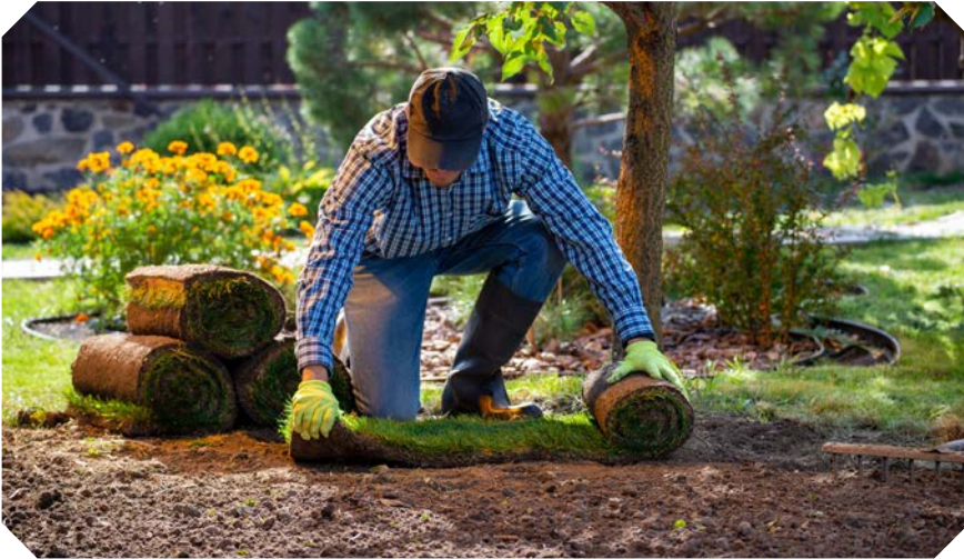
Görsel 3.3: Çim kalıpların döşenmesi
