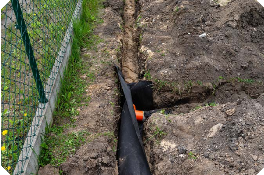
Görsel 2.2: Drenaj borularının toprağa yerleştirilmesi
