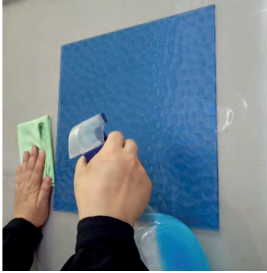
Görsel 4.206: Cam silme suyunun püskürtülmesi
