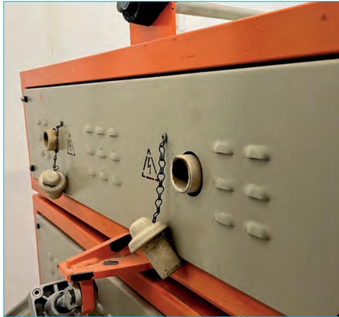
Görsel 5.82: Havalandırma deliklerinin açılması
