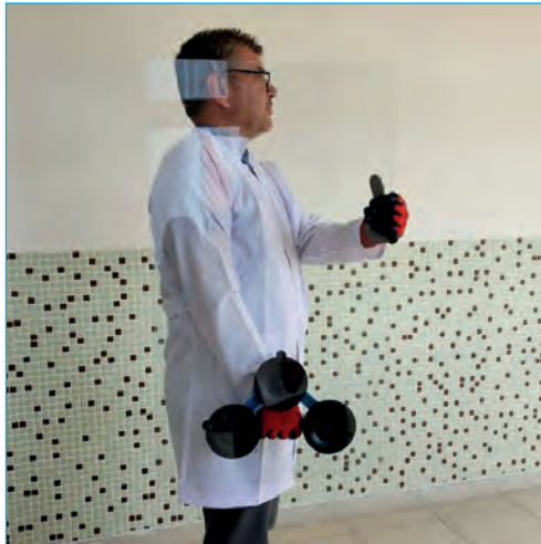
Görsel 4.47: Camın vakumlu tutma aracı ile taşınması
