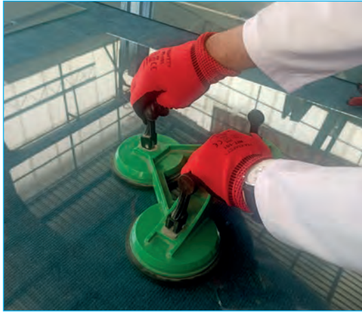
Görsel 4.37: Mandallı vantuzun yapıştırılması
