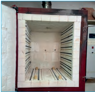
Görsel 5.26: Zemine ayakların yerleştirilmesi
