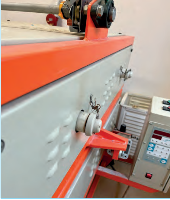
Görsel 5.80: Havalandırma deliklerinin kapatılması
