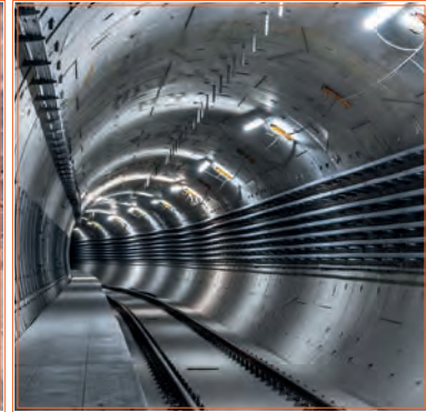
Görsel 3.8: Metro tüneli
