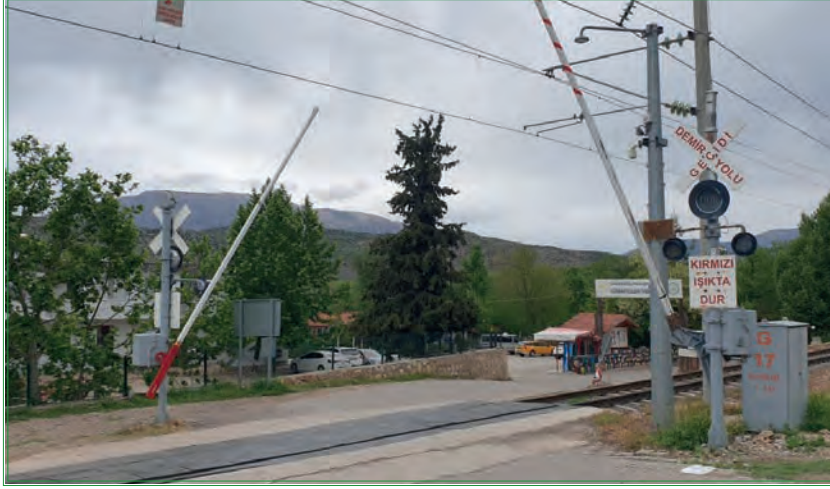
Görsel 4.5: Otomatik bariyerli hemzemin geçit (Geçiş açık)
