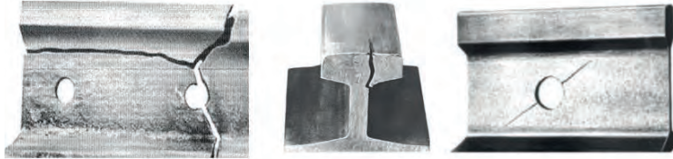
Kırık ve çatlak raylar
