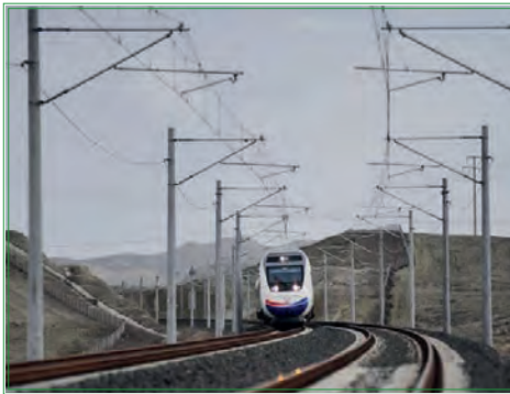
Görsel 4.17: Beton direkler
