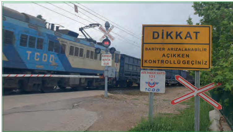
Görsel 4.4: Otomatik bariyerli hemzemin geçit (Geçiş kapalı)
