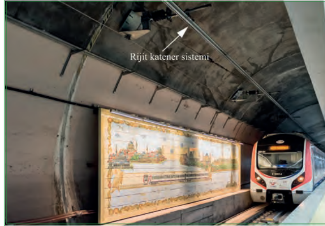
Görsel 4.19: Rijit katener sistemi (Marmaray Tüneli)
