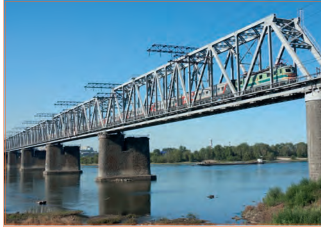
Görsel 3.12: Kompozit köprü
