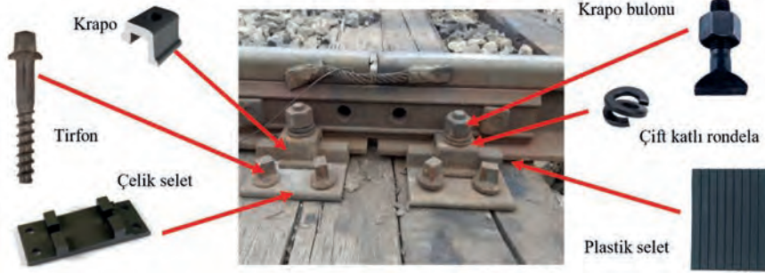
Görsel 3.19: K tipi bağlantı malzemeleri
