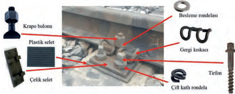
Görsel 3.21: KS tipi bağlantı malzemeleri
