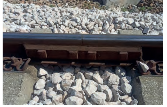
Görsel 2.5: Rayları birbirine bağlayan malzemeler
