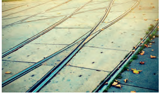
Görsel 2.2: Balastsız üstyapı
