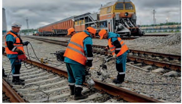
Görsel 2.7: Demiryolu hat geometri çalışması
