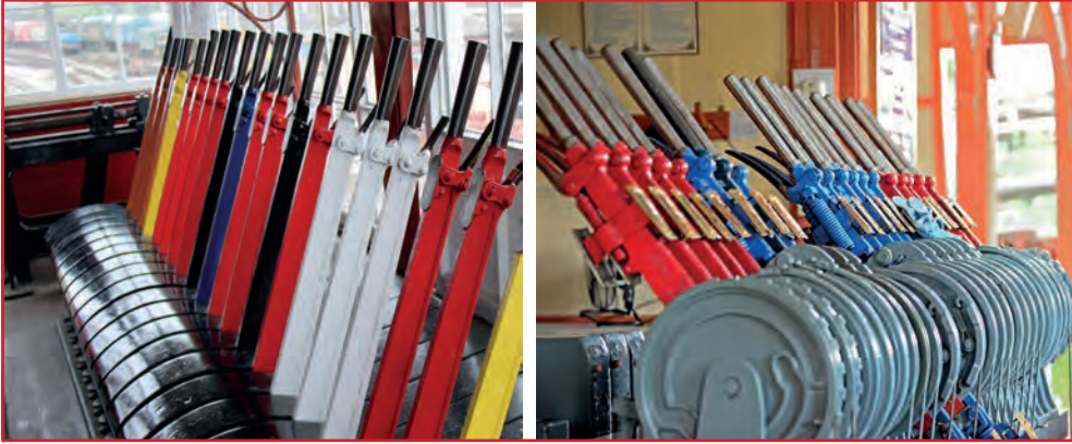
Görsel 4.9: Mekanik interlocking (anlaşılan) sistemi
