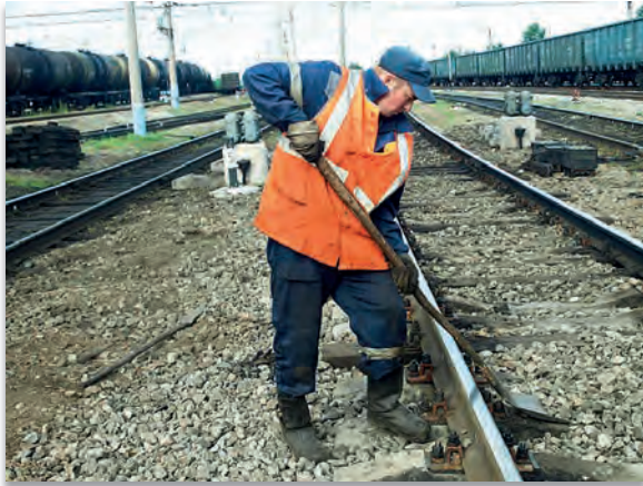
Görsel 9.4: Travers aralarının elenen balast ile doldurulması
