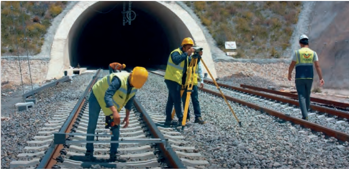
Görsel 9.5: Demiryolunun düşey eksen arızalarının nivo ile ölçülmesi
