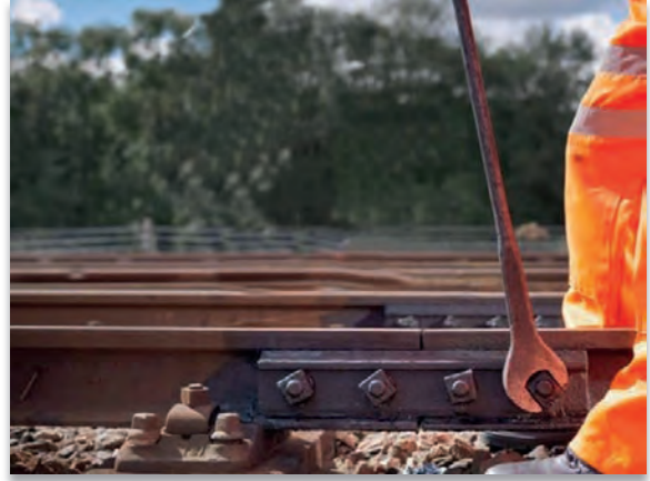
Görsel 9.6: Küçük malzemelerin sıkılması
