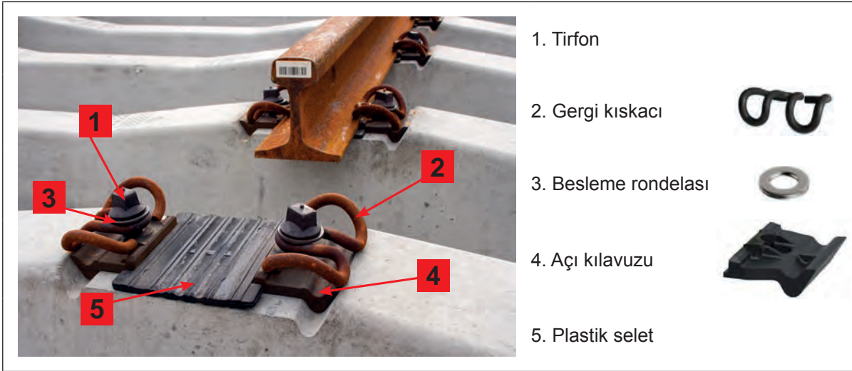
Görsel 3.11: HM tipi bağlantı malzemeleri
