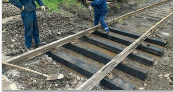
Görsel 9.3: Kirlenen balastın temizlenerek travers aralarının boşaltılması
