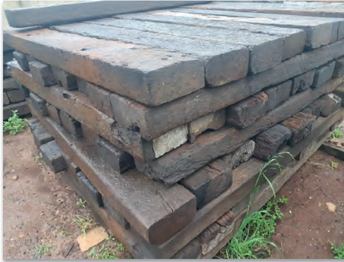
Görsel 12.4: Izgara şeklinde istiflenmiş ahşap traversler
