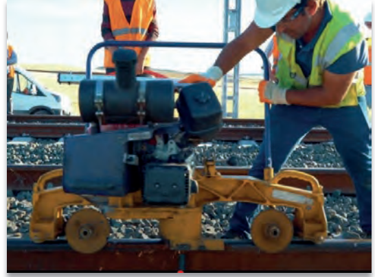
Görsel 13.5: Ray profili taşlama makinesi
