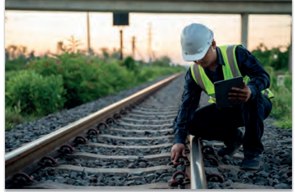
Görsel 9.2: Bakım öncesinde yolun kontrol edilmesi ve arızaların tespiti
