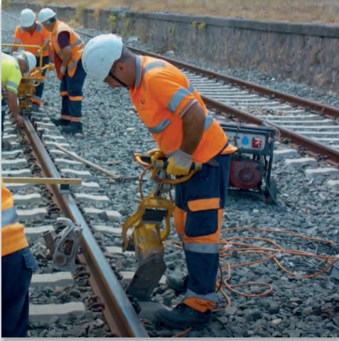
Görsel 13.3: Elektrikli el buraj makinesi
