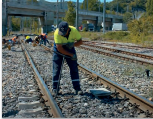
Görsel 1.2: Demiryolunda el tirfonöz anahtarı ile çalışma
