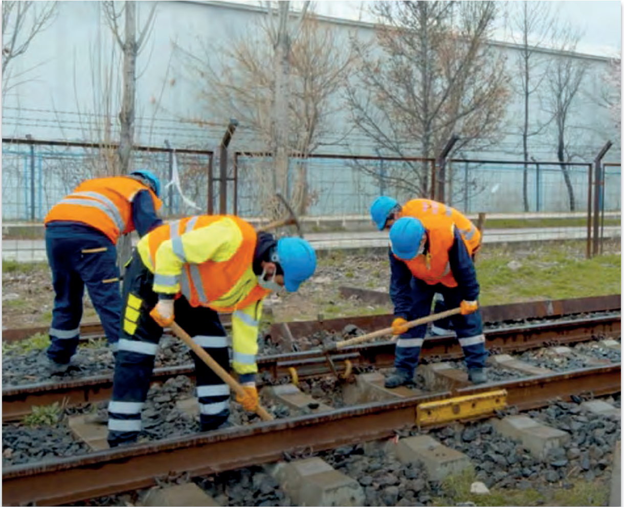
Görsel 9.8: Travers altlarının sıkıştırılması (buraj)
