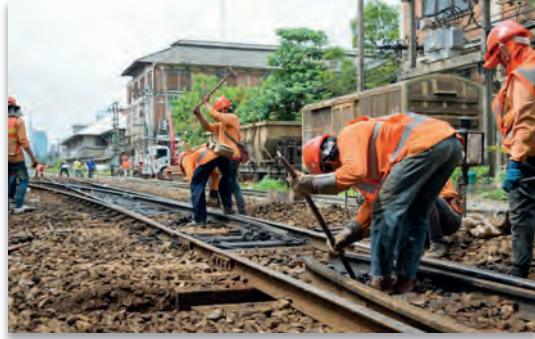
Görsel 1.1: Demiryolunda manivela ile çalışma
