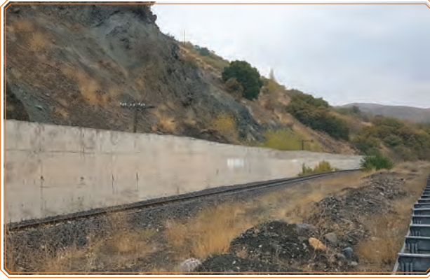
Görsel 5.6: Betonarme istinat duvarı
