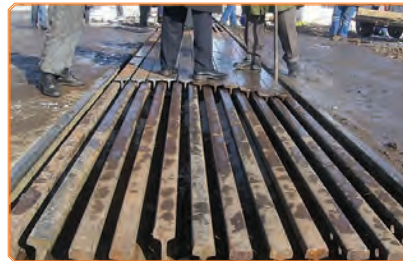
Görsel 4.25: Ray kaplamalı hemzemin geçit uygulaması
