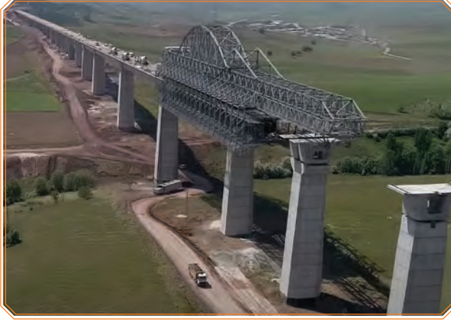
Görsel 3.15: Prefabrik tabliye montajında kullanılan kavalet
