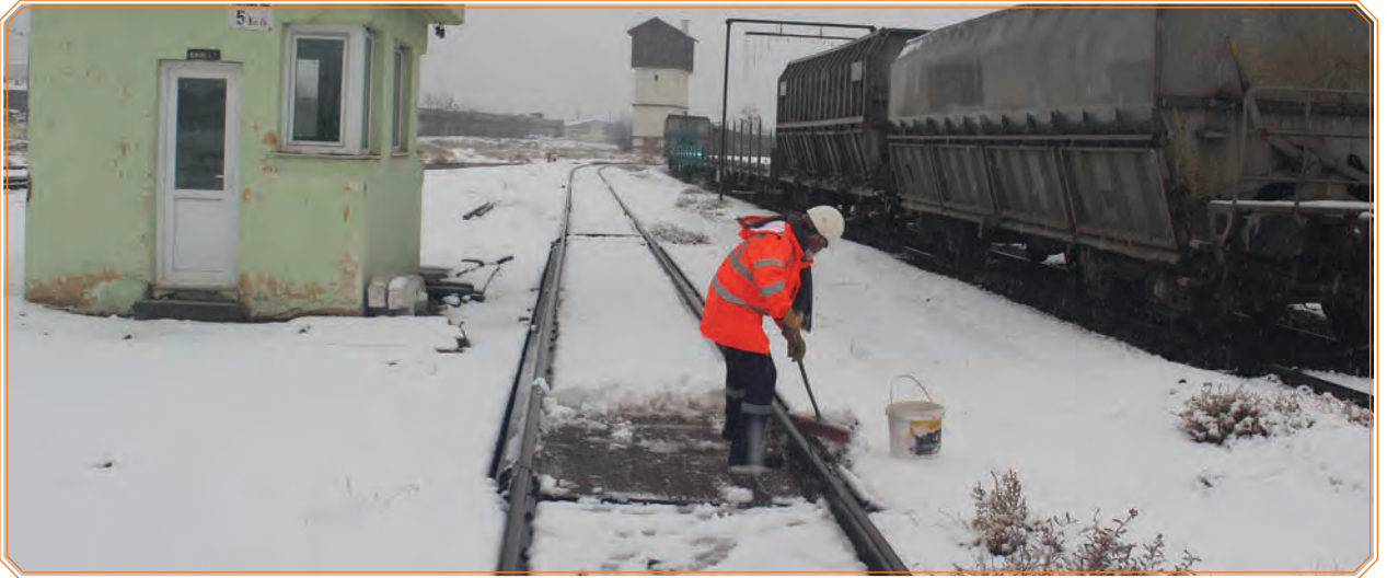
Görsel 6.9: Tartım tertibatı ve kanallarının temizlenmesi
