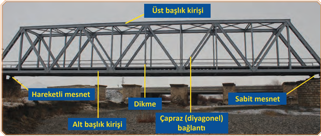
Görsel 3.29: Çelik köprü ve elemanları
