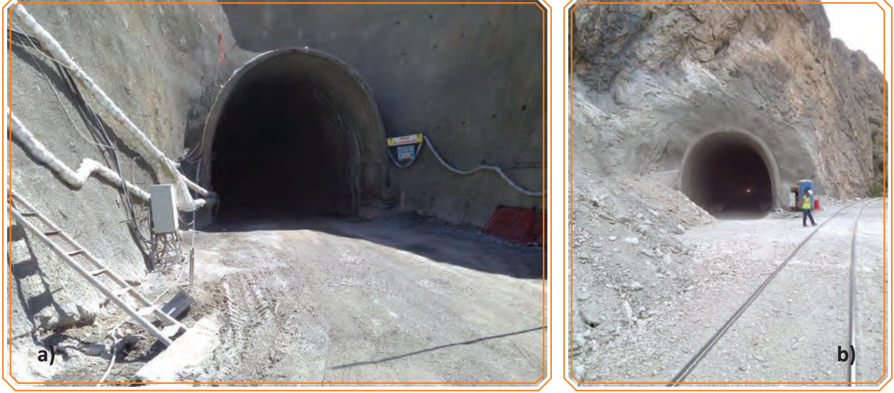
Görsel 2.12: (a,b) Tünel yapımı
