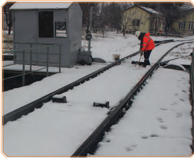
Görsel 6.10: a) Döner köprünün temizlenmesi
