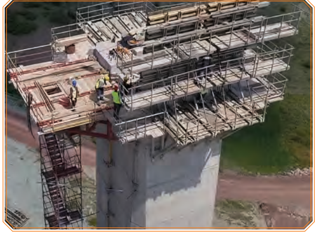
Görsel 3.16: Köprü ayağı inşaatı kavaleti
