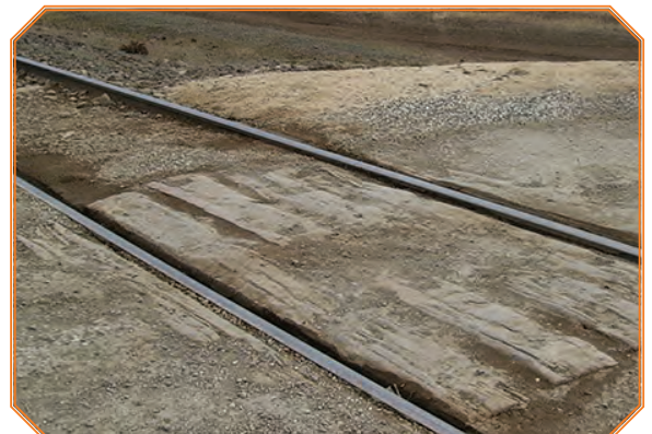
Görsel 4.7: Ahşap travers kaplamalı hemzemin geçit
