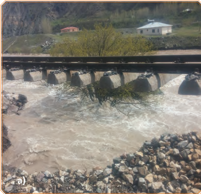
Görsel 3.30: (a,b) Taşkın sonrası altyapının kayması
