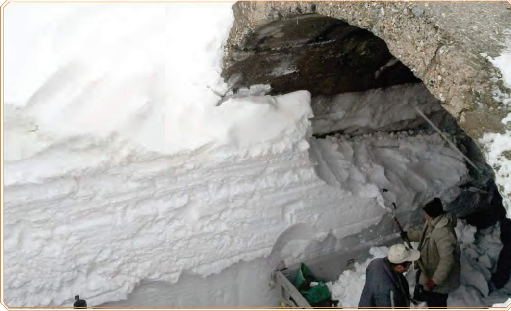
Görsel 6.28: Tünel içindeki karın vagonlarla taşınması
