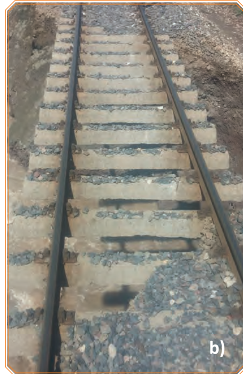
Görsel 3.30: (a,b) Taşkın sonrası altyapının kayması
