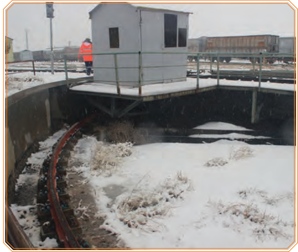
Görsel 6.10: b) Döner köprü tertibatının temizlenmesi
