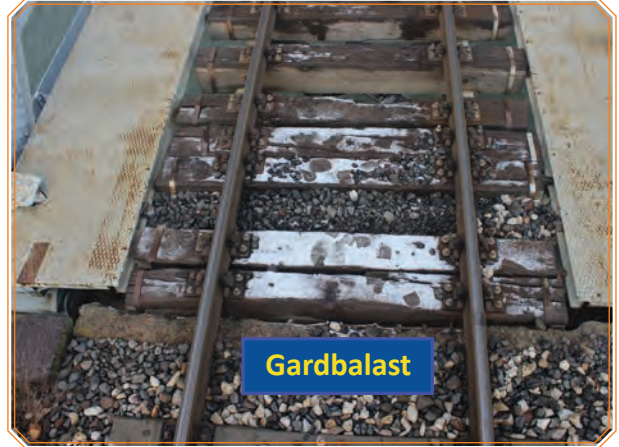
Görsel 3.14: Balast tutucu duvar
