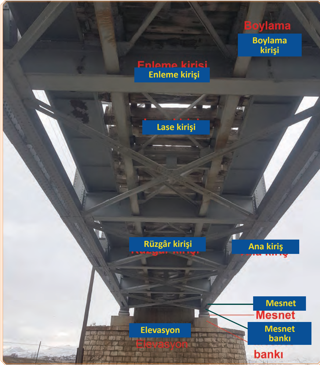
Görsel 3.28: Çelik köprünün alttan görünüşü ve elemanları
