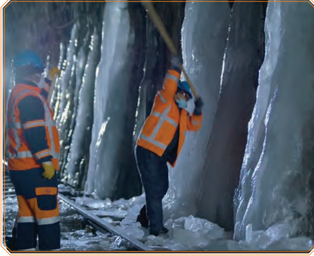
Görsel 6.11: Tünel içi sarkıt temizleme çalışması
