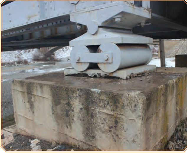
Görsel 3.11: Hareketli mesnet ve mesnet bankı
