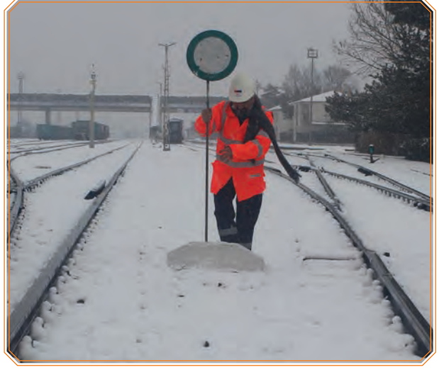
Görsel 6.8: Limit taşının yerinin diskle belirlenmesi
