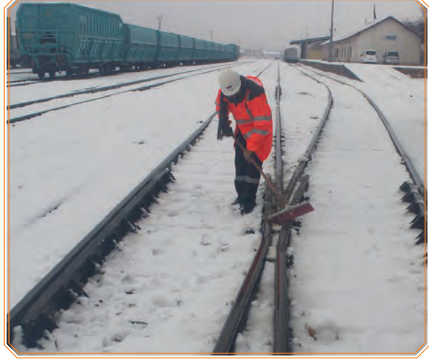
Görsel 6.5: Göbek ve kontrrayların temizlenmesi
