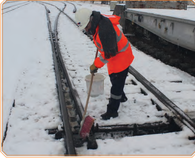
Görsel 6.4: Dil ile yaslanma rayı arasındaki boşluğun temizlenmesi
