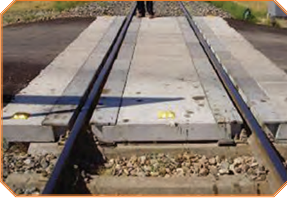
Görsel 4.9: Prefabrik kaplamalı hemzemin geçit
