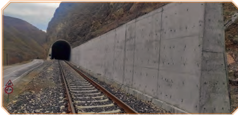
Görsel 12.9: Betonarme istinat duvarı
