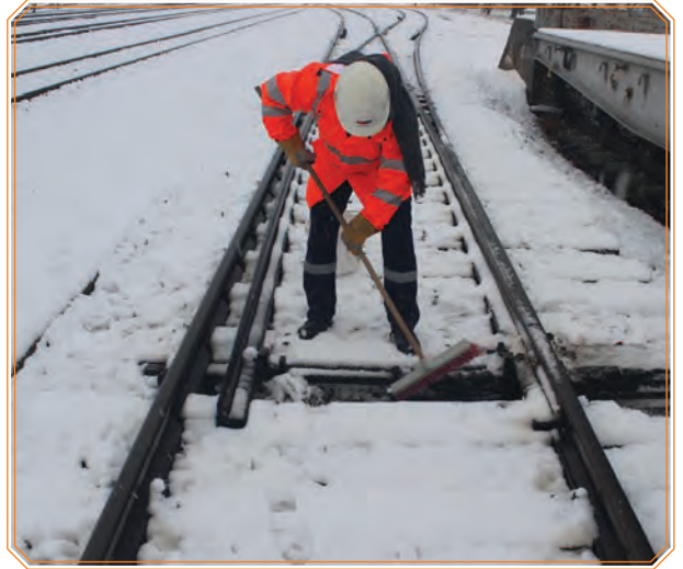
Görsel 6.3: Manevra tertibatının temizlenmesi
