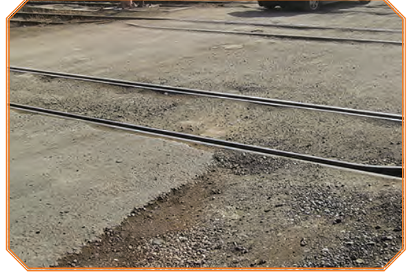
Görsel 4.8: Asfalt kaplamalı hemzemin geçit
