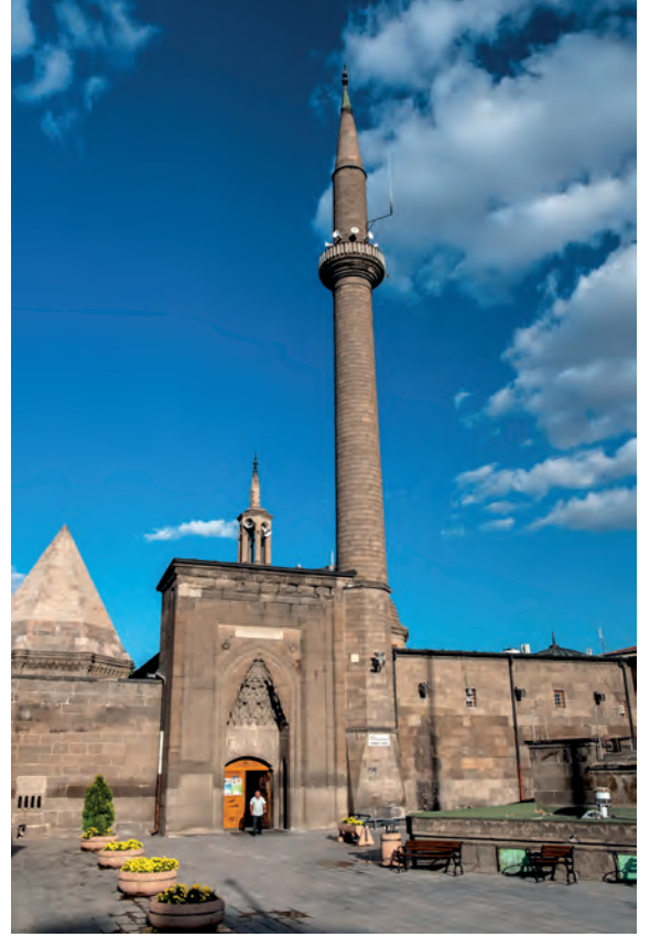
Görsel 1.30: Hunat Hatun Külliyesi dış görünümü, Kayseri
