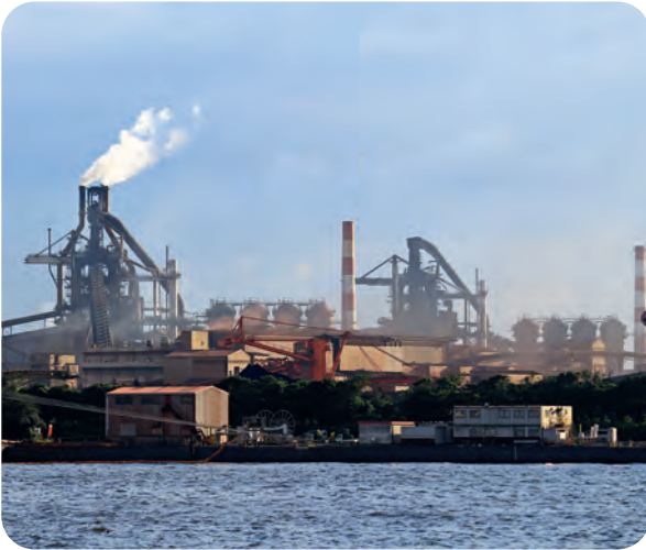
Görsel 2.9: Kıyı tesisi
