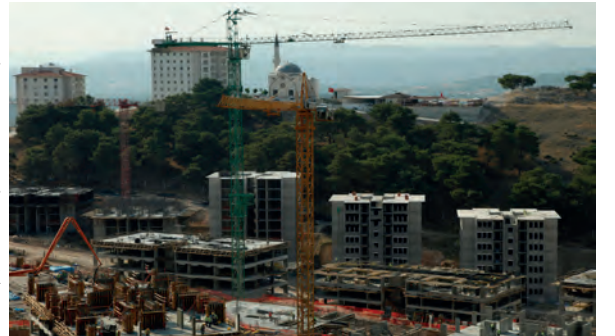
Görsel 2.40: İnşaat yapım süreci
