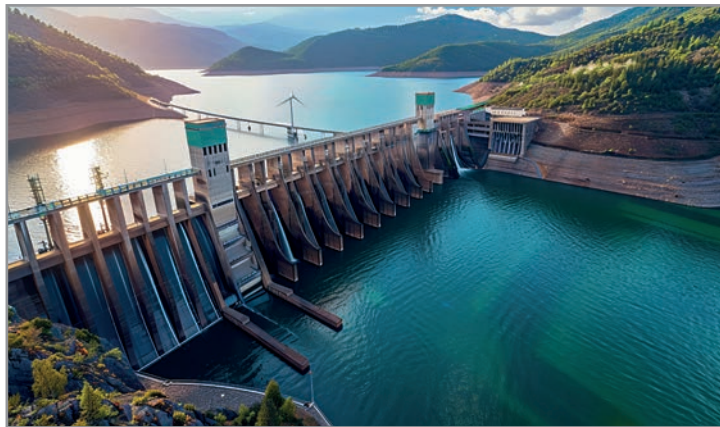
Görsel 1.5: Hidrolik enerji üretim tesisi
