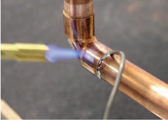
Görsel 1.114: Bakır boruların sızdırmaz lehimlenmesi
