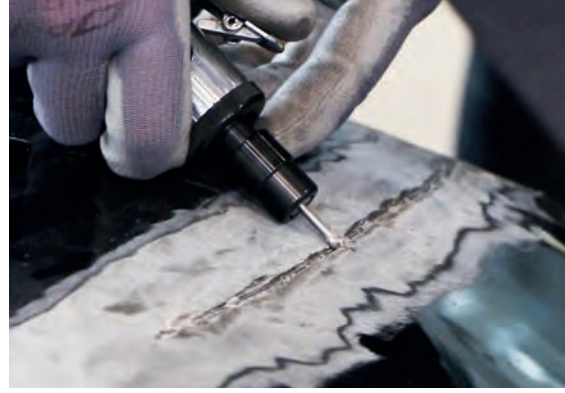
Görsel 3.41: Hasarlı kısma oluk açılması
