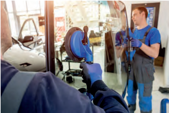
Görsel 5.14: Cam vantuzları ile cam taşınması
