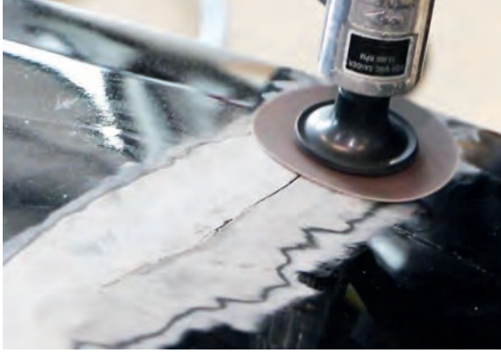
Görsel 3.40: Hasarlı bölgenin zımparalanması
