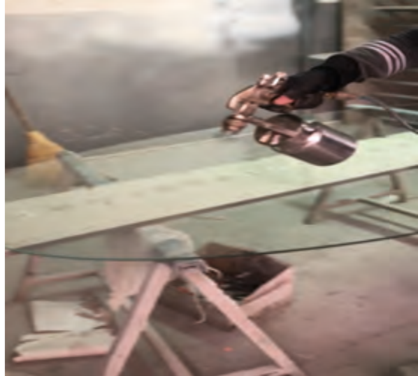
Görsel 5.28: Cam yüzeylere bariyer uygulaması
