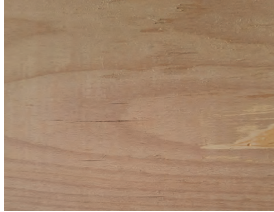
Görsel 1.3: Çatlamış bir yüzey görüntüsü
