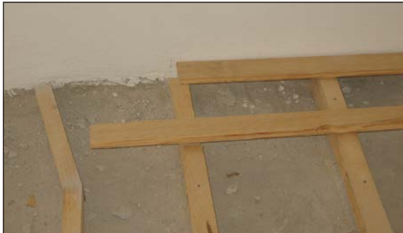
Görsel 5.70: Tahta ek yeri ızgarasını yerleştirme
