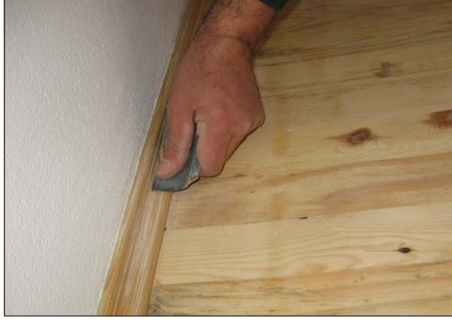
Görsel 5.94: Astarlanmış süpürgeliğin perdahı
