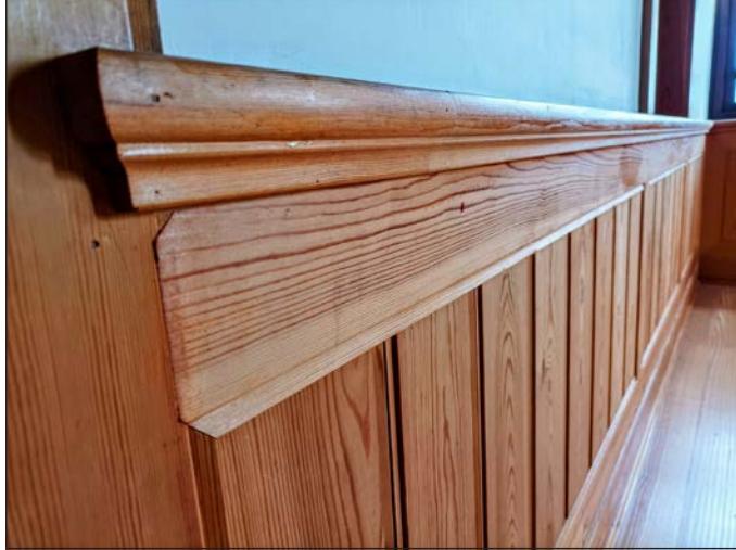
Görsel 4.60: Ahşap kaplamada küpeşte uygulaması
