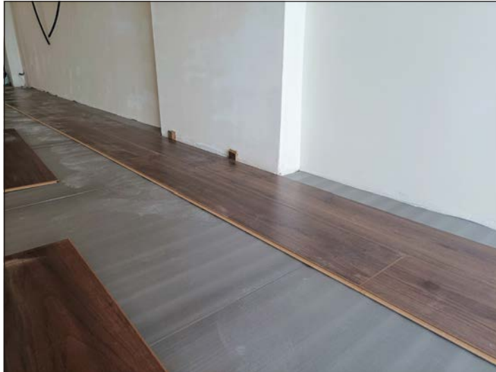
Görsel 5.46: Duvar dibi ilk sıra ve çalışma boşluğu kamaları
