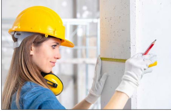
Görsel 4.19: Beton kolon ölçüsü alma
