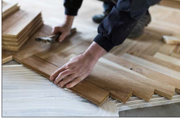
Görsel 5.38: Tutkallı parke döşemesi yapma
