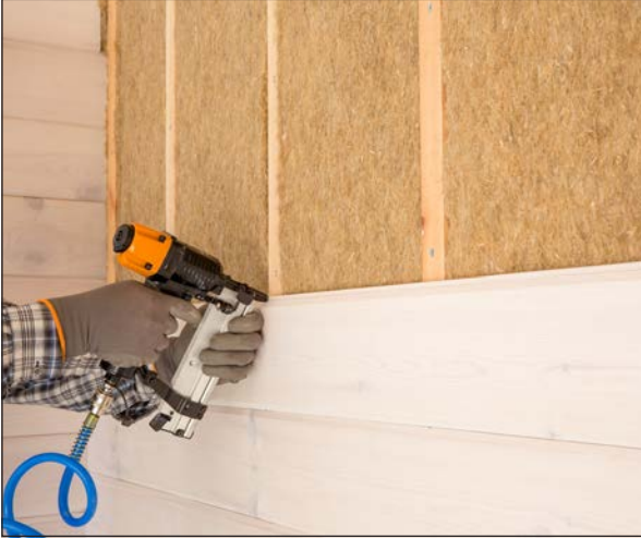
Görsel 4.55: Çivi tabancası ile lambri tahtası montajı
