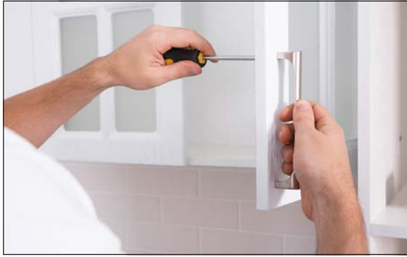
Görsel 3.62: Kulp montajı yapma
