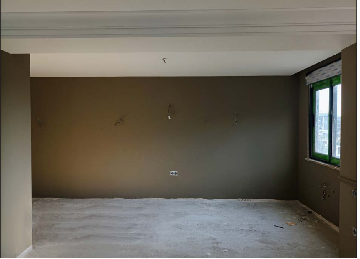
Görsel 1.45: Mutfak alanı cephe duvarı
