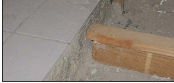
Görsel 5.67: Yüksekliği ek parça ile ayarlanmış kadron
