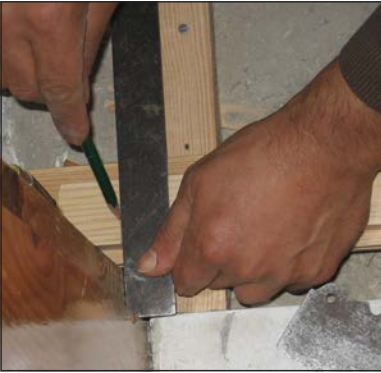
Görsel 5.75 a, b, c: Döşeme tahtasını kertme için markalama ve kertme sonrası yerine montajı
