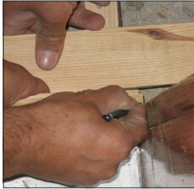
Görsel 5.75 a, b, c: Döşeme tahtasını kertme için markalama ve kertme sonrası yerine montajı
