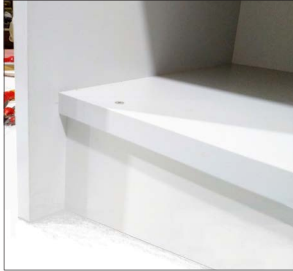
Görsel 3.17: Alt parçaya vida ile bağlanmış kapatıcı baza
