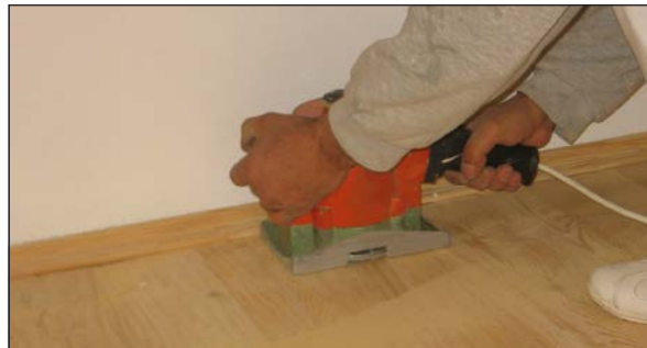
Görsel 5.86: Disk zımpara makinesi ile perdah yapma
