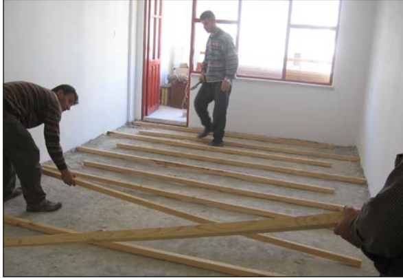
Görsel 5.68: Kadronların ızgara şeklinde dizilmesi
