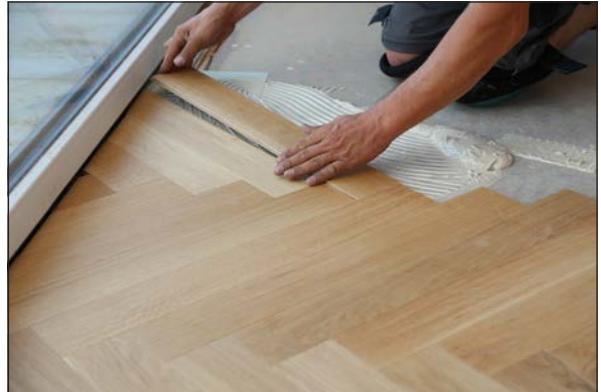
Görsel 5.40: Parke tahta montajı
