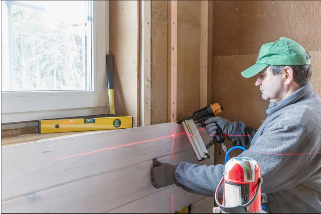
Görsel 4.57: Lambri tahtasının çivi ile montajı
