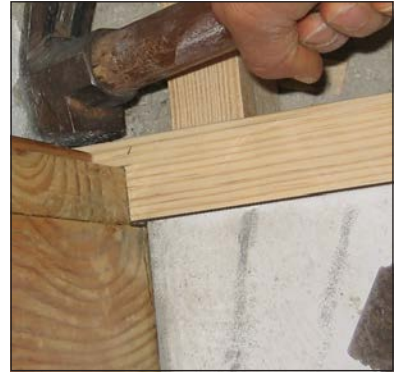
Görsel 5.75 a, b, c: Döşeme tahtasını kertme için markalama ve kertme sonrası yerine montajı
