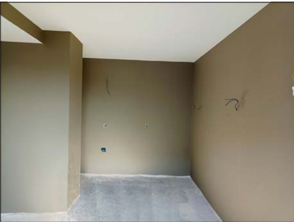
Görsel 1.46: Mutfak alanı sol duvar
