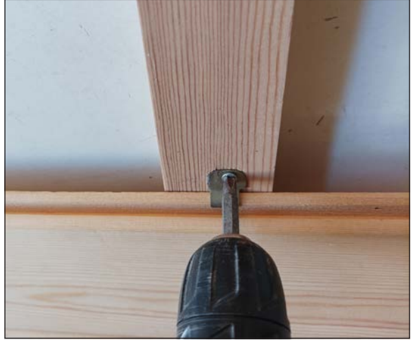
Görsel 4.56: Metal tırnaklar ile lambri tahtası montajı
