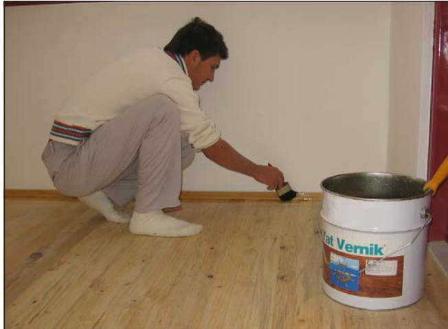
Görsel 5.95: Fırça ile son kat verniği pervazlara sürme
