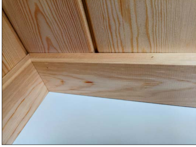
Görsel 4.59: Montajı tamamlanmış süpürgelik
