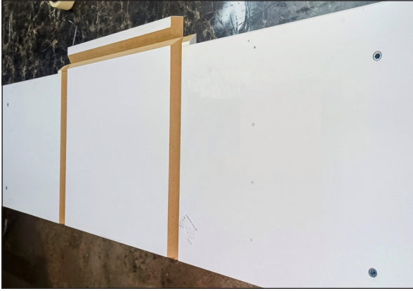
Görsel 3.31: Açırtayında kesilmiş taç montajı
