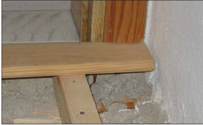
Görsel 5.76: Pervaz altına tahta montajı
