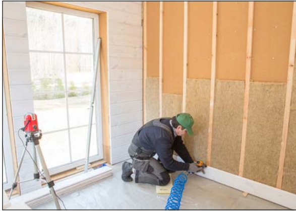
Görsel 4.51: Birinci sıra lambri tahtasını yerleştirme ve ızgaraya bağlama
