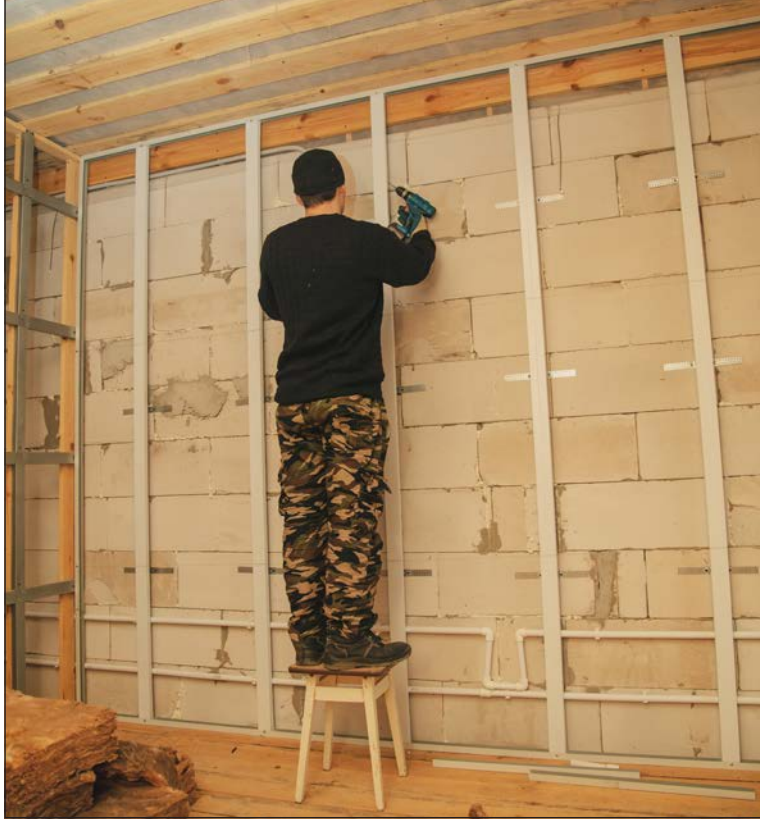
Görsel 4.45: Metal malzemeden yapılmış duvar kaplama ızgarası
