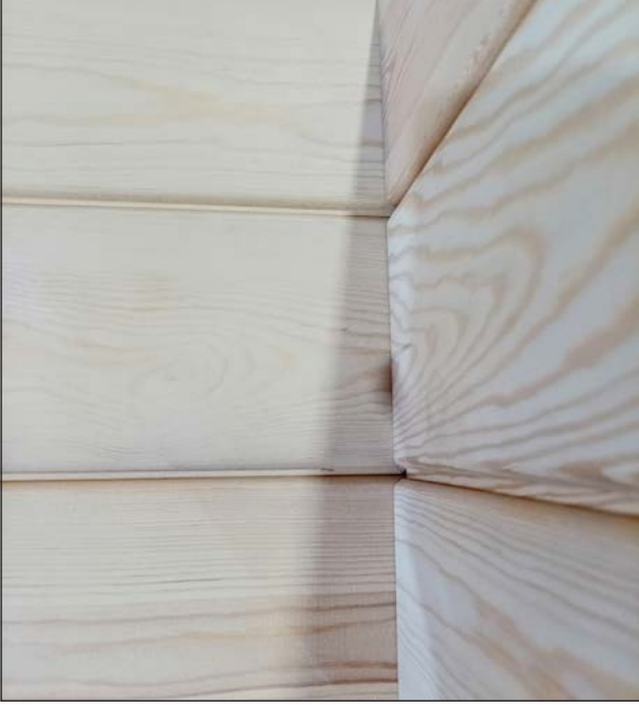
Görsel 4.46: Derz boşluğu gizli kaplama yüzeyi
