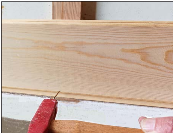
Görsel 4.52: Yatay konumdaki ilk lambri tahtasının montajı
