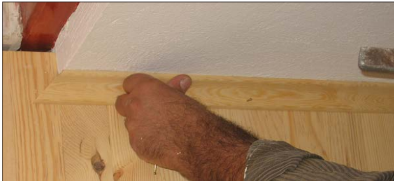
Görsel 5.82: Süpürgelik boyu ile birleştirme açısı yön kontrolü
