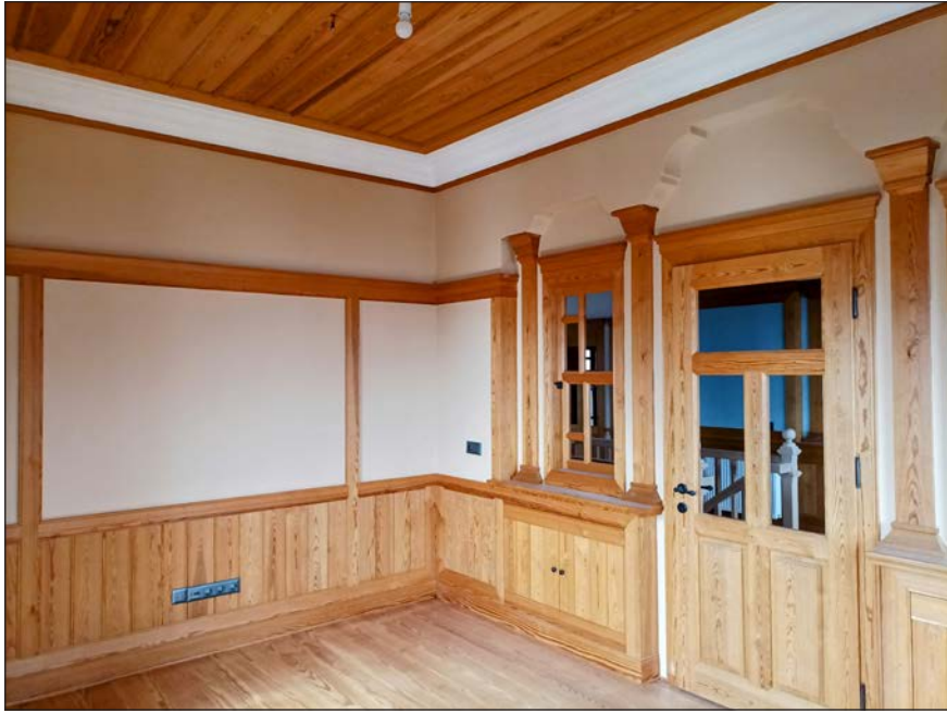
Görsel 4.1: Farklı yüzeylere ahşap kaplaması yapılmış oda
