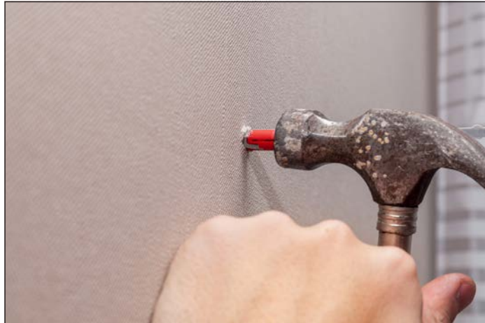
Görsel 4.42: Duvara dübel çakma
