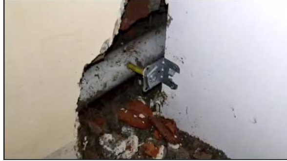
Görsel 1.52: Pis su giderine denk gelmiş duvar bağlantısı
