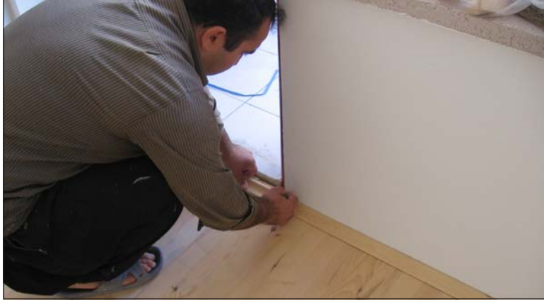
Görsel 5.81: Pervaz boyu ölçüsü markalama
