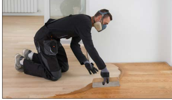
Görsel 5.84: Ahşap döşeme yüzeyini macunlama
