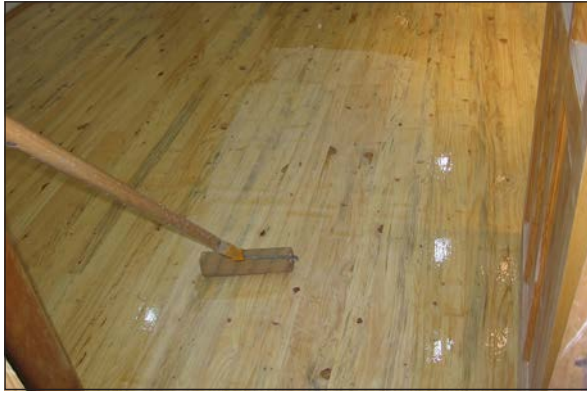
Görsel 5.93: Rulo ile dolgu verniği sürme
