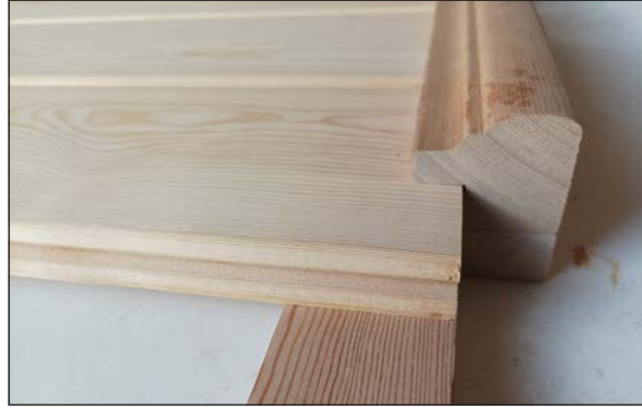
Görsel 4.43: Küpeşte uygulama detayı
