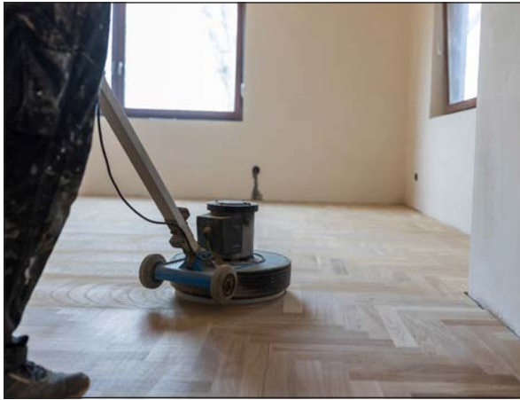
Görsel 5.88: Disk zımpara makinesi ile perdah yapma
