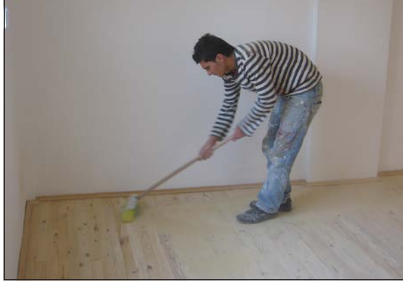
Görsel 5.89: Ahşap döşeme yüzeyini temizleme
