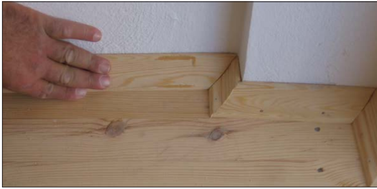
Görsel 5.83: Çivi ile montajı yapılmış süpürgelik
