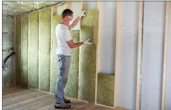
Görsel 4.44: Yalıtım malzemesi yerleştirme
