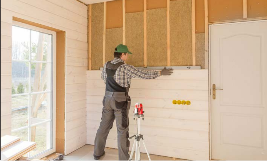
Görsel 4.58: Elektrik tesisat kasaları yerleştirilmiş kaplama yüzeyi
