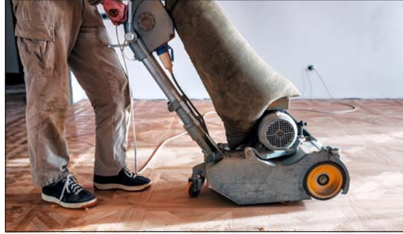
Görsel 5.85: Tank zımpara makinesi ile perdah yapma
