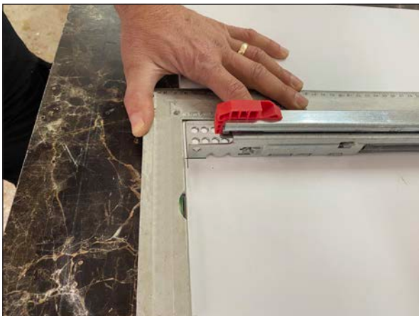
Görsel 2.21: Gönye ile tandem rayı yerleştirme
