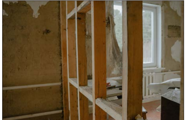
Görsel 4.7: Ahşap duvar iskeleti
