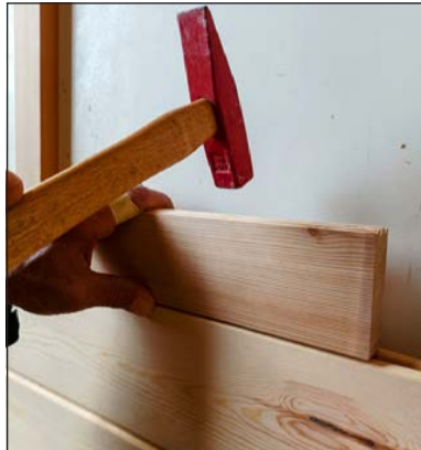
Görsel 4.54: Vurma parçası ile lambri tahtalarını takma
