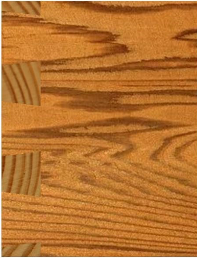
Kırılmaçıkuyruğu köşe birleştirme
