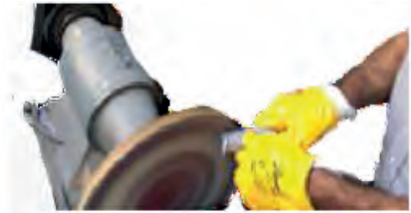
Resim 5.38: Çalışanın taşlamada pozisyonu
