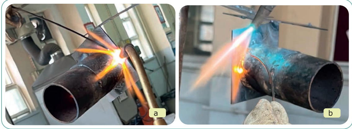
Görsel 3.4: Flanşın soldan sağa ve sağdan sol dik kaynağı
