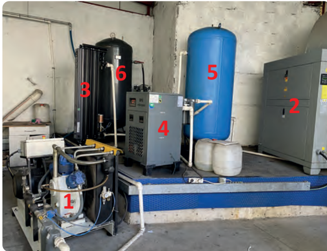
Görsel 2.12: Hava şartlandırma sistemi
