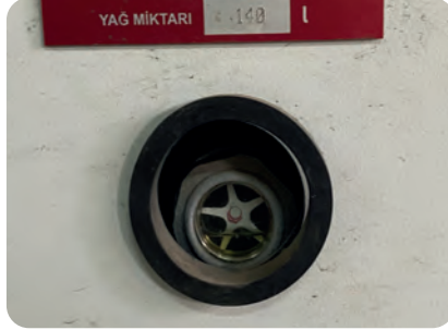
a) Yağ seviyesi gözetleme camı
