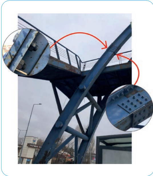
Görsel 1.3: Yaya üst geçidinde sökülebilir birleştirme elemanları
