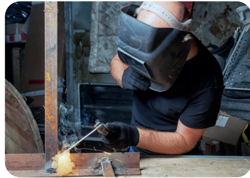
Görsel 5.9: Ark kaynağı yapılışı
