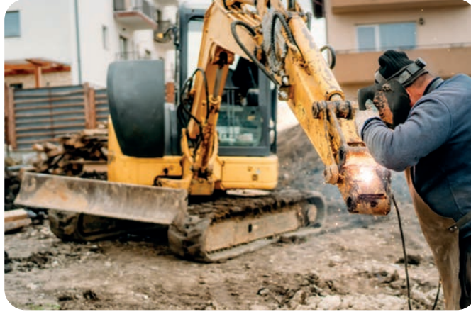
Görsel 6.21: Kepçenin aşınan parçalarının şantiyede kaynak edilmesi
