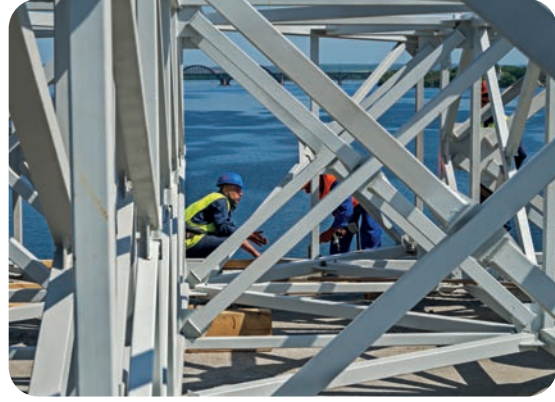
Görsel 3.13: Çelik konstrüksiyon montajı
