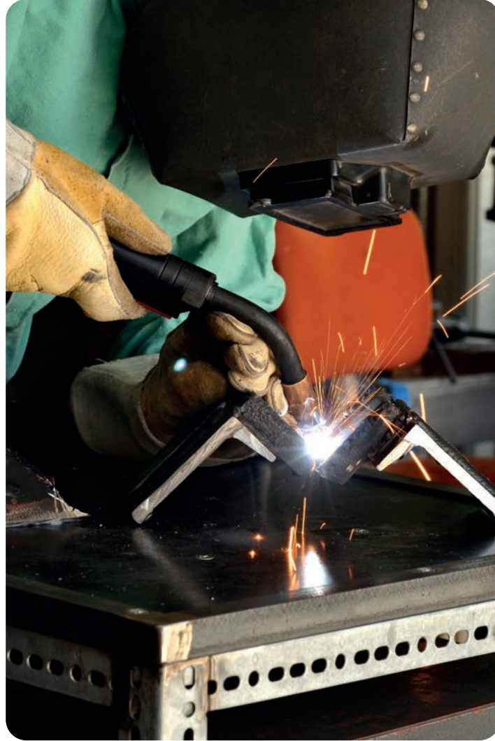
Görsel 6.24: Dolgu kaynağının yapılması
