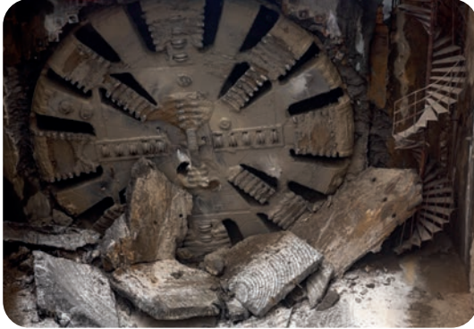
Görsel 6.28: Tünel inşaatında kullanılan deliciler
