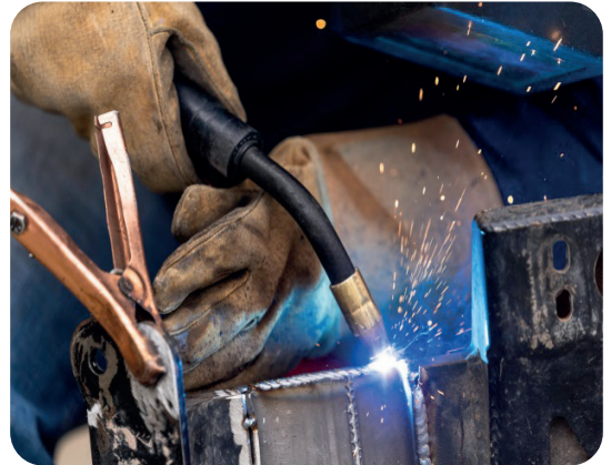
Görsel 5.2: MAG Kaynağı
