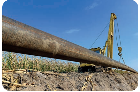
Görsel 7.2: Boru döşeme
