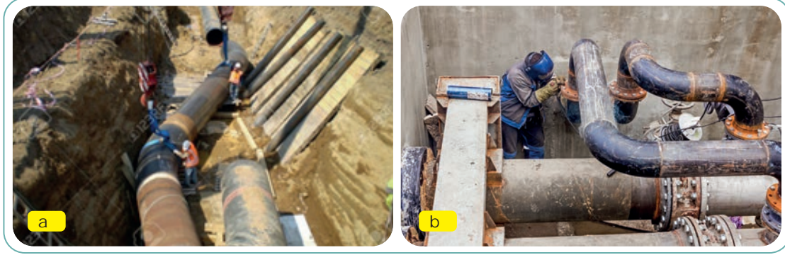
Görsel 7.5: Büyük çaplı boruların kaynağı
