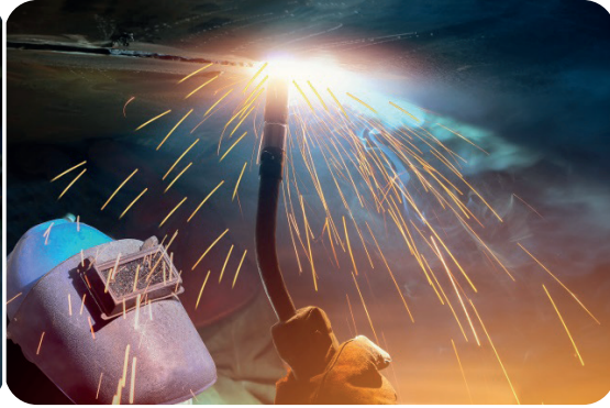
Görsel 1.9: MAG kaynağı
