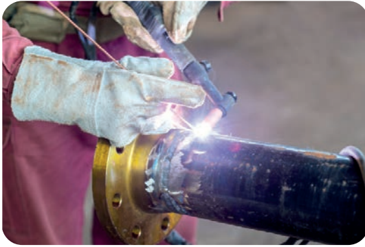
Görsel 5.28: Pirinç flanş kaynağı
