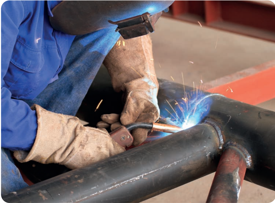
Görsel 7.16: Ana tesisattan kol alma ve T birleştirme
