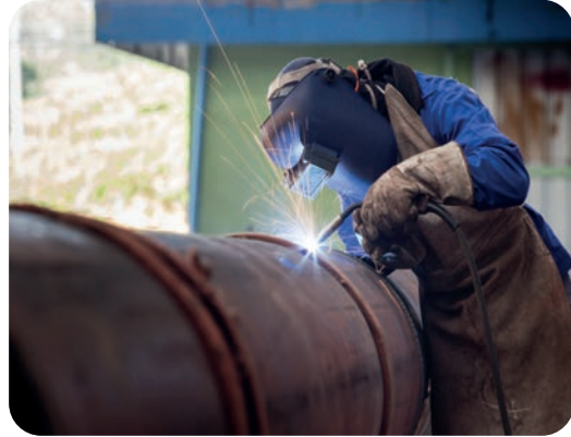
Görsel 3.6: Boru kaynağı
