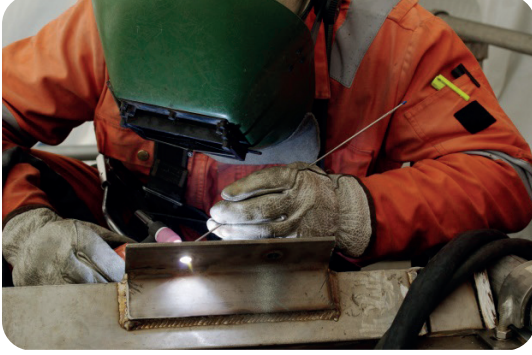
Görsel 5.26: Yatayda iç köşe onarım kaynağı
