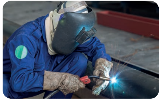
Görsel 7.4: MIG-MAG boru kaynağı
