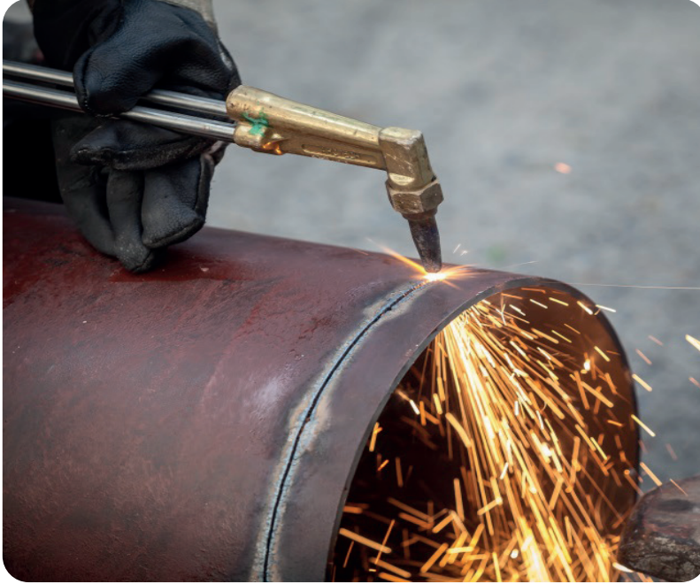
Görsel 5.16: Oksi-gaz kaynağı ile kesme işlemi
