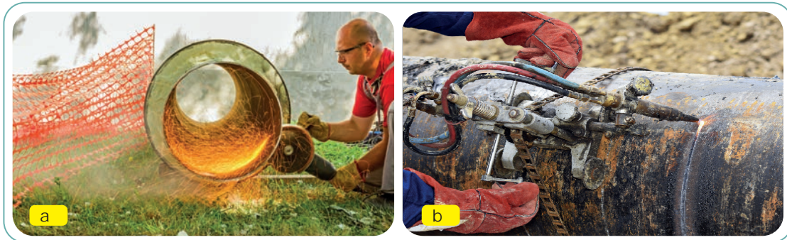
Görsel 7.6: Büyük çaplı boruların taşla ve oksî-gazla kesilmesi
