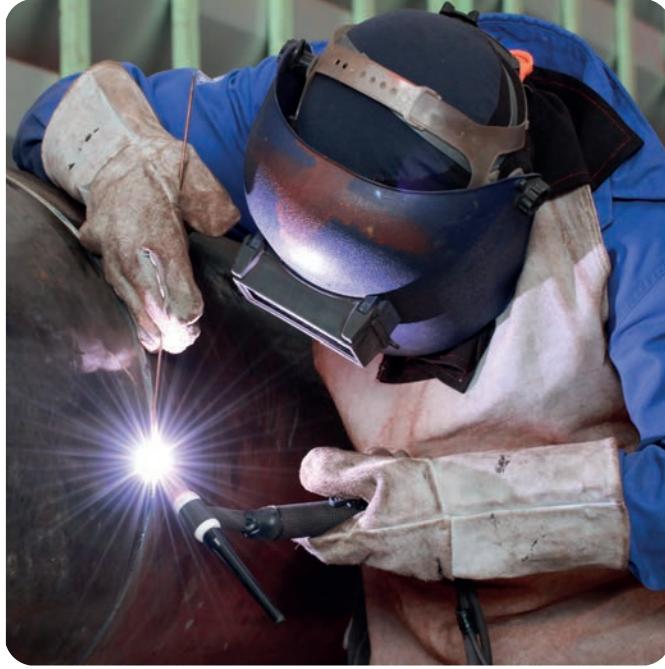
Görsel 7.10: Büyük çaplı borunun TIG ile kaynatılması
