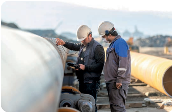
Görsel 7.14: Büyük çaplı borunun kaynak kontrolü
