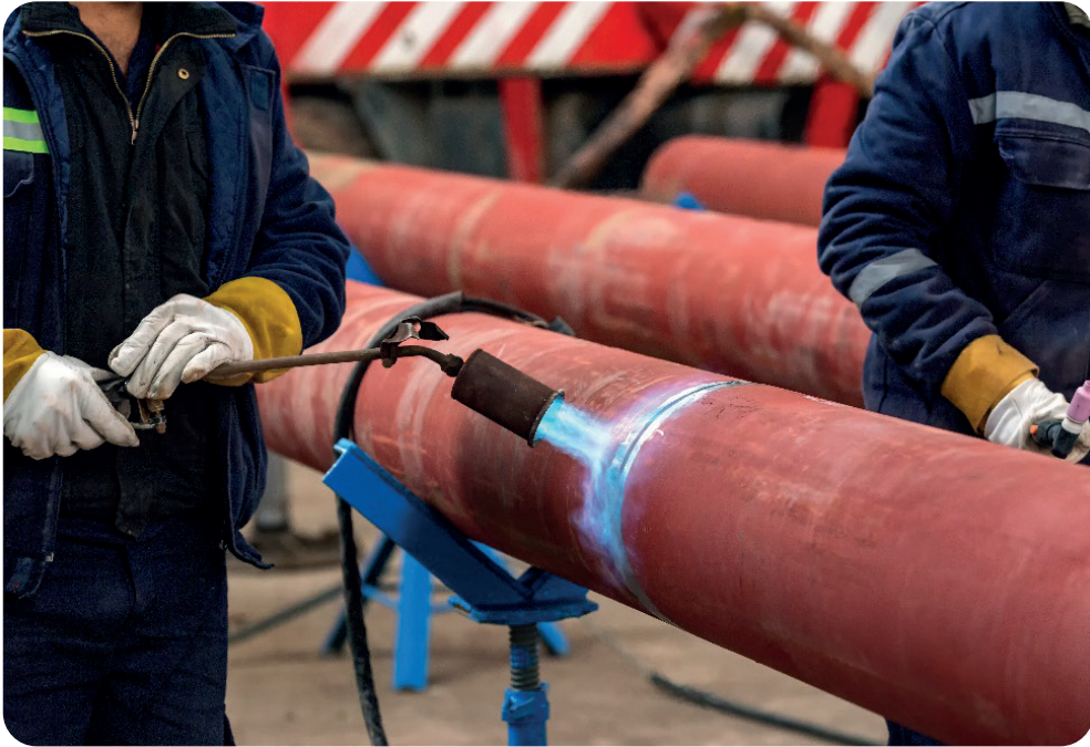
Görsel 7.5: Büyük çaplı borunun kaynak öncesi tavllanması
