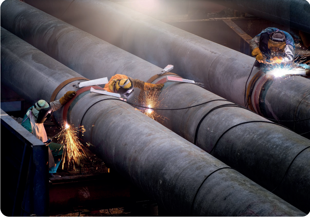
Görsel 7.2: Boru hatlarında kaynak yapılması
