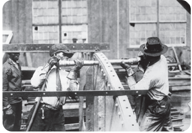
Görsel 1.18: Amerika'da pnömomatik çekiçlerle perçin birleştirilmesi yapan dok işçileri
