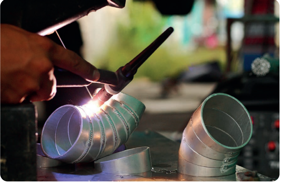
Görsel 6.1: TIG kaynağıyla boru birleştirme
