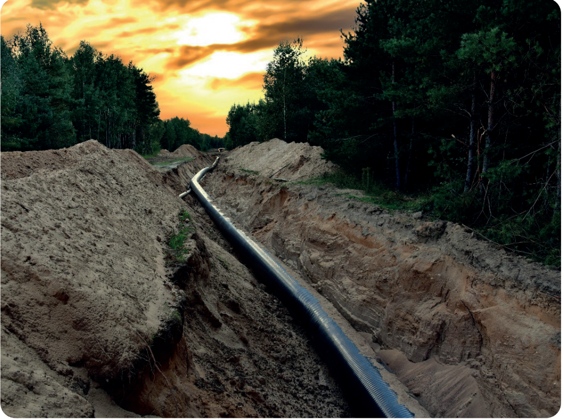
Görsel 7.1: Doğal gaz boru hattı
