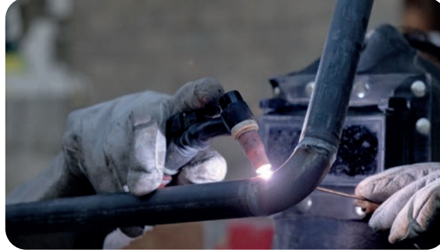
Görsel 7.19: TIG kaynağıyla dirsek birleştirme
