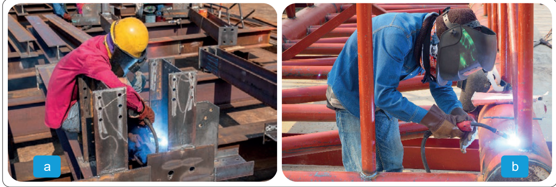
Görsel 6.2 a, b: Konstrüksiyon yapımında kaynak
