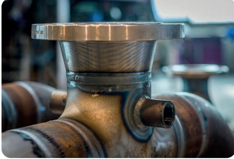
Görsel 7.3: Ek alınmış ve kaynakla birleştirilmiş büyük çaplı boru tesisatı
