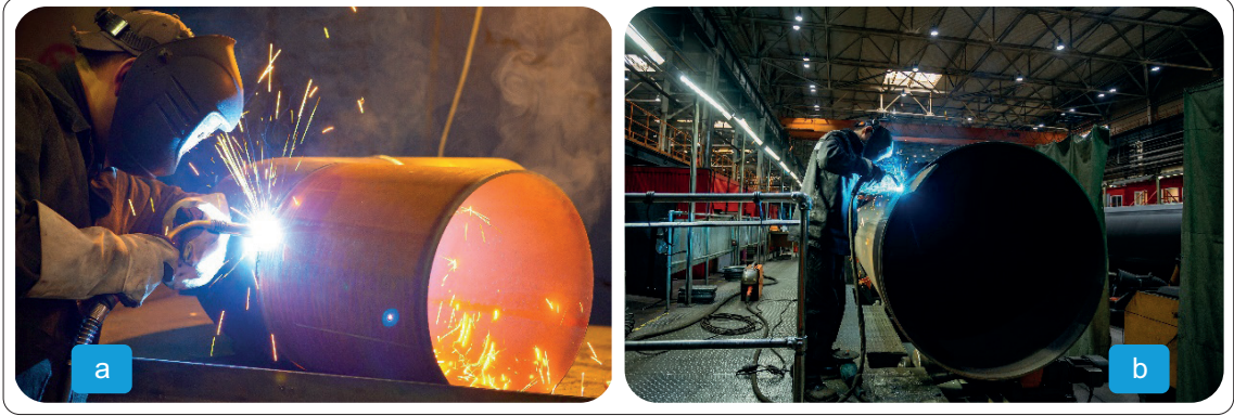
Görsel 7.12 a, b: Büyük çaplı boruların dıştan MIG-MAG kaynağı
