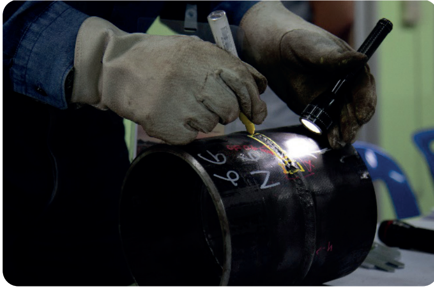
Görsel 7.16: Boya ile kaynak kontrolü
