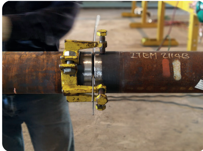
Görsel 7.7: Kaynak öncesi boruların sabitlenmesi
