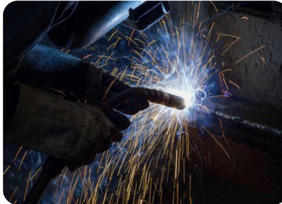
Görsel 4.6: Yan (duvar, korniş) kaynağı
