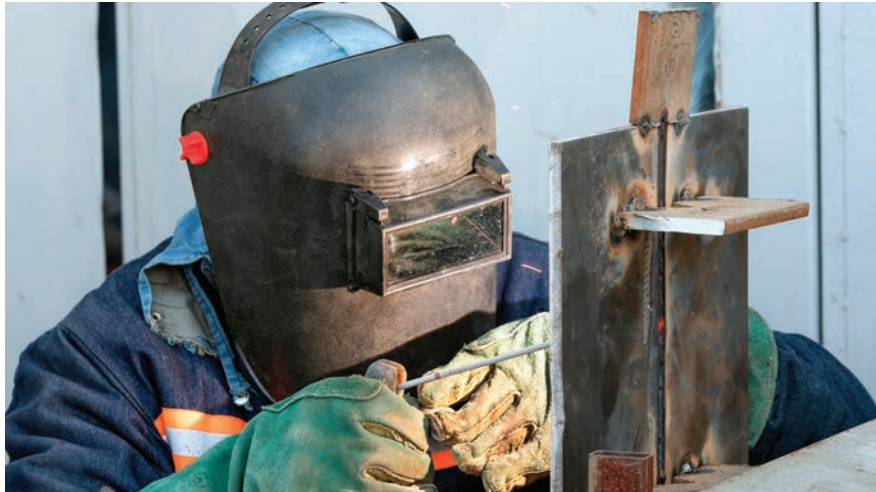
Görsel 3.3: Elektrik ark ile dik kaynak
