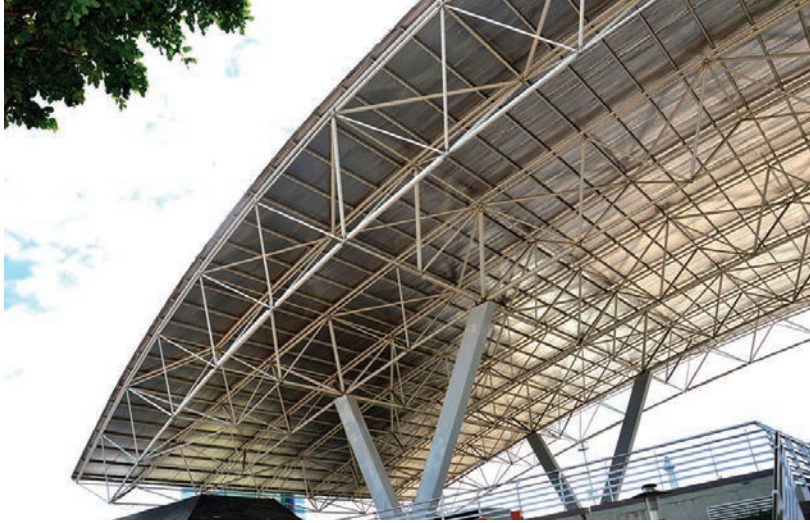
Görsel 9.4: Çelik yapı
