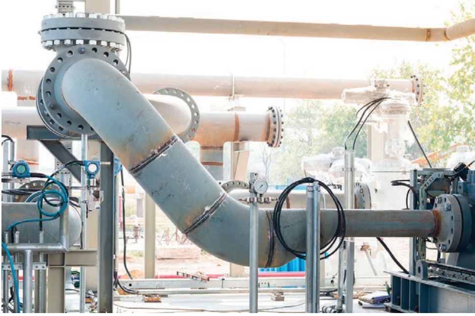
Görsel 9.14: Flanşla birleştirilmiş boru donanımı
