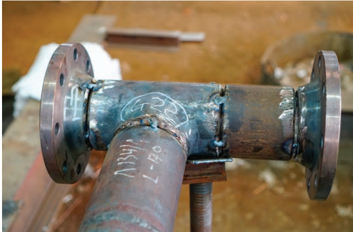
Görsel 9.16: Flanşın puntalanması
