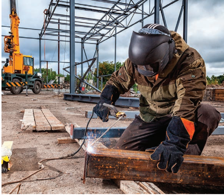
Görsel 5.4: Yerde montaj kaynak uygulaması
