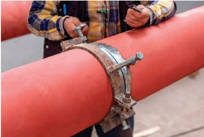
Görsel 9.10: Boruların ağızlamasında kullanılan makine
