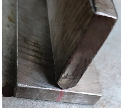
Görsel 1.13: K kaynağında puntalama
