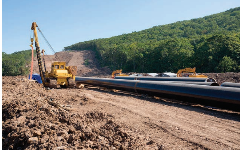
Görsel 9.3: Petrol boru hattı montajı
