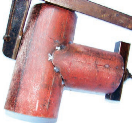
Görsel 9.22: Arakesit çıkarılarak alıştırılan boruların puntalanması
