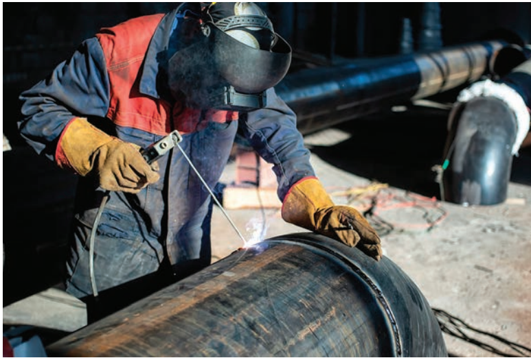
Görsel 5.6 : Bazik elektrotla kaynak uygulaması
