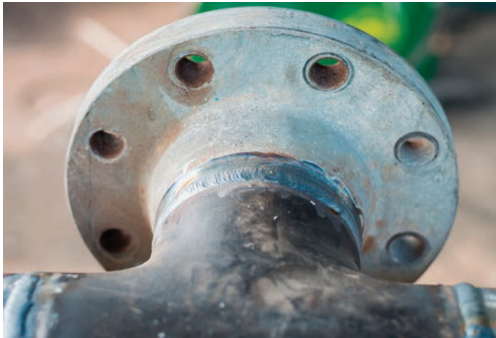
Görsel 9.17: Flanşın dıştan kaynatılması
