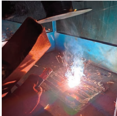
Görsel 5.3: Kaynak yapılırken havalandırma
