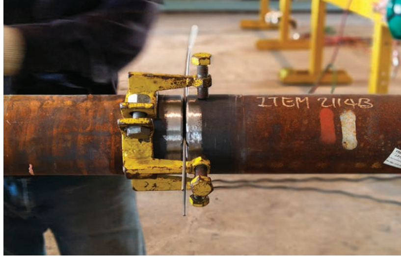
Görsel 9.11: Boruların ağzlamasında kullanılan aparat
