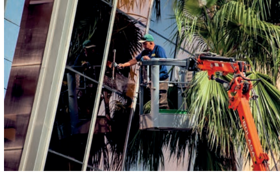
Görsel 4.32: Uygulama öncesi sepetli vinçle temizlik
