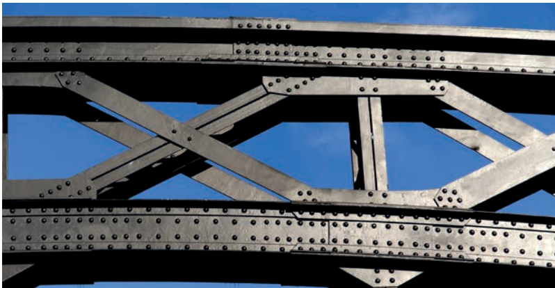
Görsel 4.20: Perçinli birleştirme kullanılmış bir köprü
