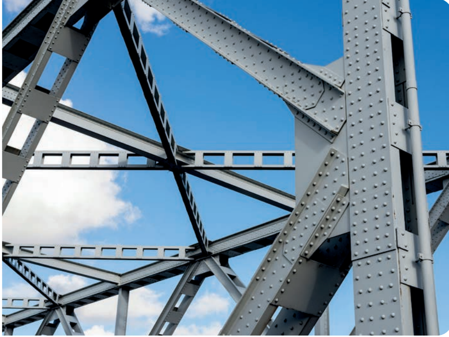
Görsel 1.128 : Perçinlerin çelik yapılarda kullanılması
