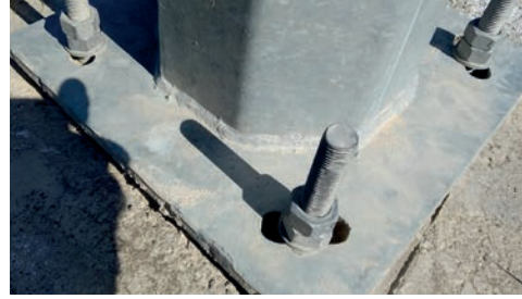
Görsel 1.40: Somunların saplama ile bağlantısı
