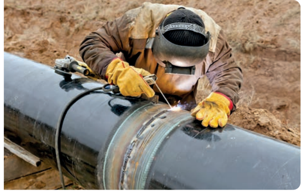
Görsel 1.136: Elektrik ark kaynağı
