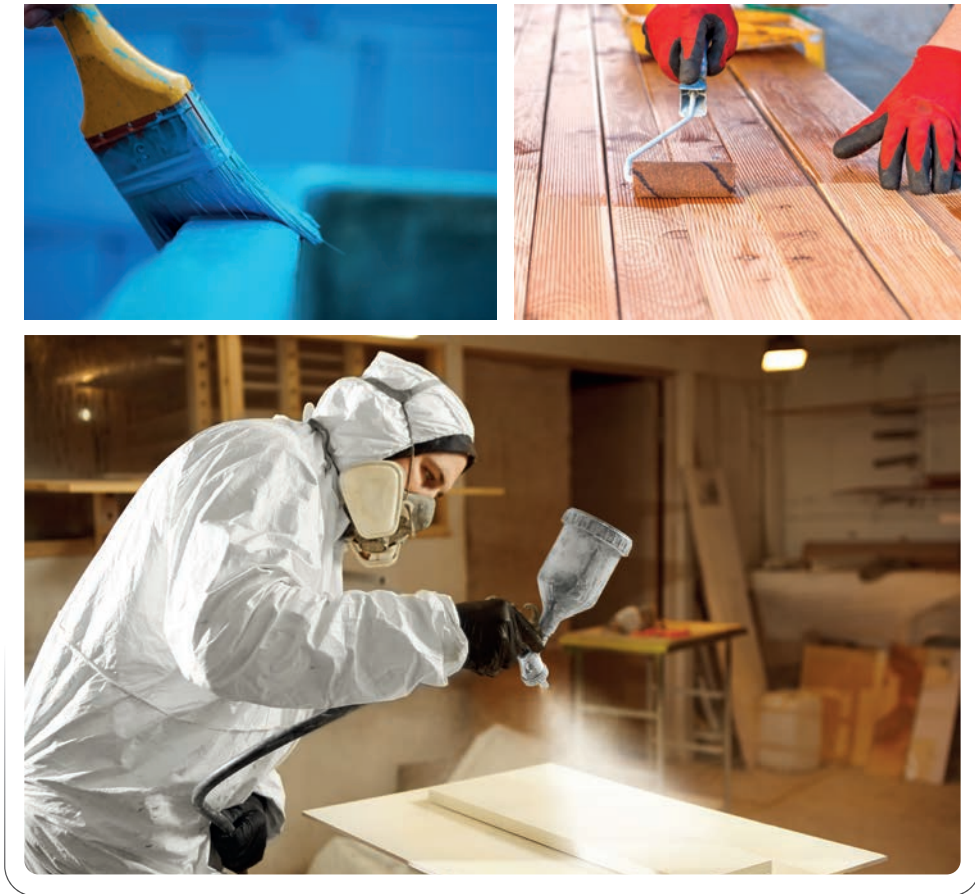
Görsel 1.52: Model boyama yöntemleri
