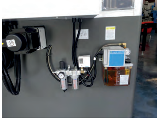
Görsel 5.7: Yağlama ünitesi
