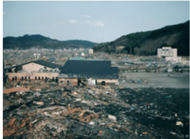
Görsel 3.13: Tsunami sonrasında oluşan yıkıntılar
