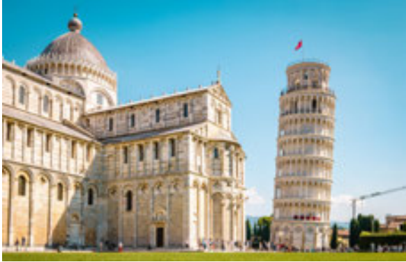
Görsel 1.30: Pisa Kulesi. İncetaneli yumuşak zeminlerdeki düşük dayanımın sonucunda sebep olduğu temelde oturma ve şev yenilmeleri.
