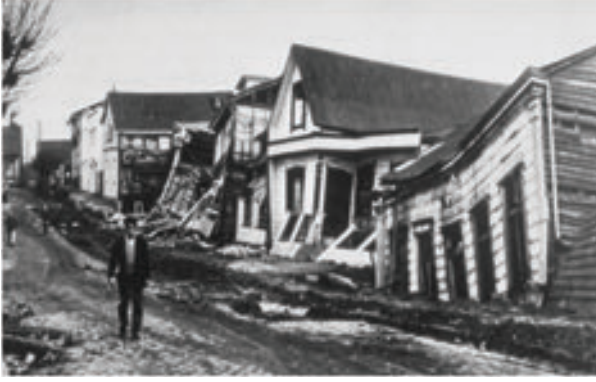
Görsel 3.6: 1960 Şili depreminde yıkılan evler
