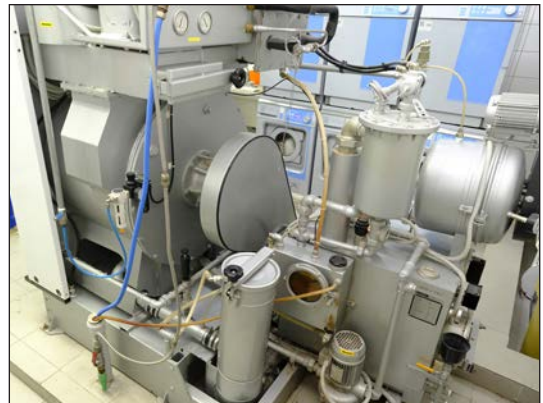
Görsel 4.8: Sızıntı kontrolü yapılacak bölümler
